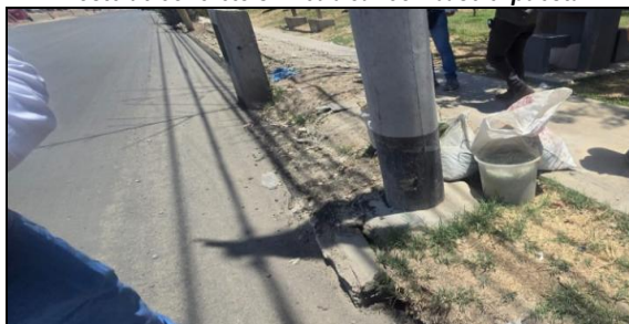
Imagen n.º 46 Poste de concreto sin reubicar con base expuesta
