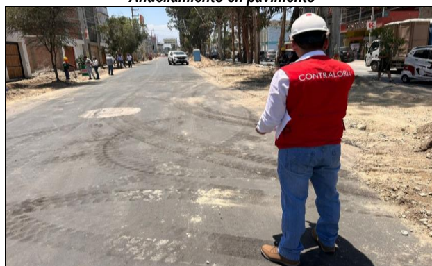
Imagen n.º 10 Ahuellamiento en pavimento
