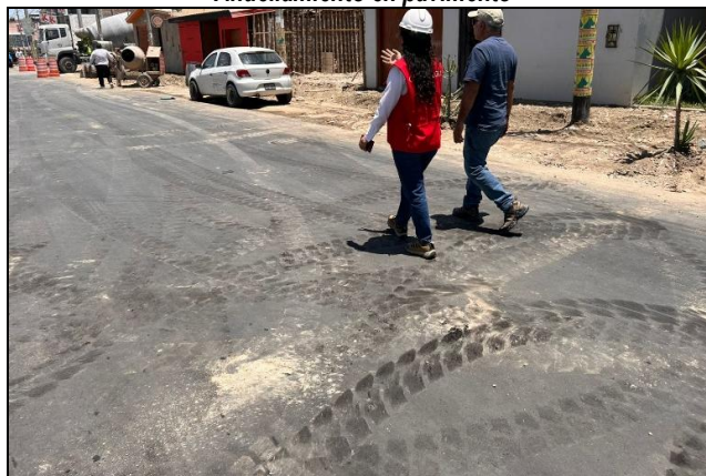
Imagen n.º 9 Ahuellamiento en pavimento
