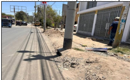
Imagen n.º 54 Poste de concreto sin reubicar, con cimienta expuesta, próximo a pavimento asfaltado
