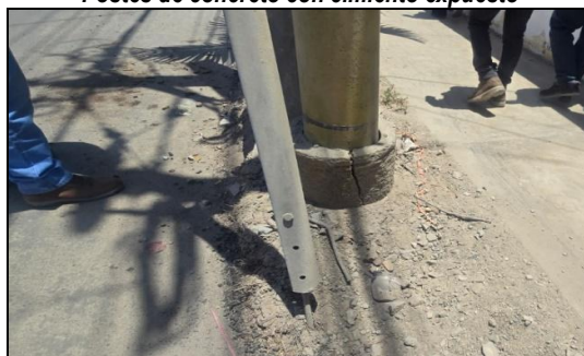
Imagen n.° 50 Postes de concreto con cimiento expuesto
