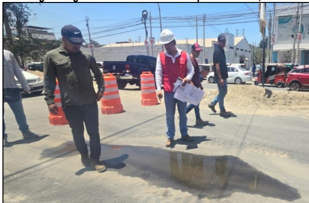
Imagen n.º 18 Escaso aniego de agua estancada sobre la carpeta asfáltica, con desniveles
