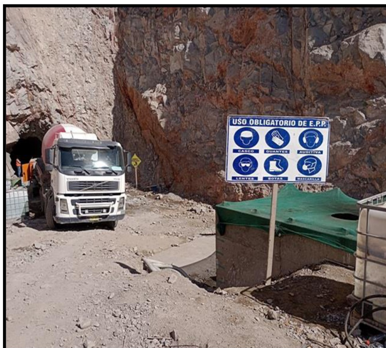
Fuente: Imagen n.º27 de Acta de inspección física n.º01-2025-CG/GRIC-SCC-PETACC Elaborado por: Comisión de Control
