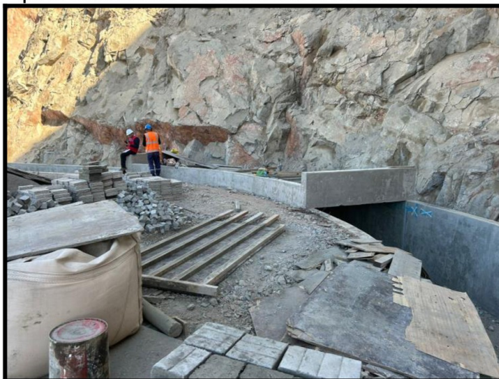
Imagen n.º 19 Área del almacenamiento del cemento Yura de 1.5 ton que se está utilizando en la elaboración de los dados de concreto
