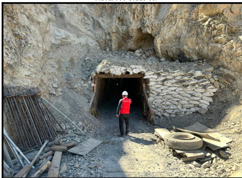
Imagen n.º 17 Componentes de las cerchas de acero apoyadas directamente sobre suelo natural y sin protección, en Salida del Túnel n.º 2 en el que se está ejecutando la instalación de las cimbras. Estas estructuras son de acero corrugado calidad ASTM 706 Grado 60.
