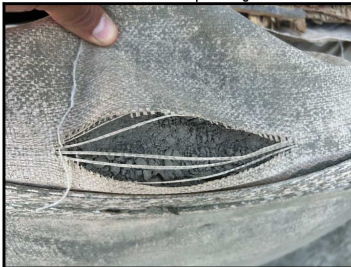
Imagen n.º 20 Cemento Yura de 1.5 ton. que se está utilizando en la elaboración de los dados de concreto presenta grumos
