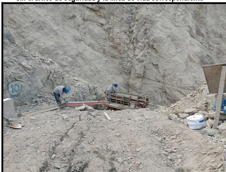
Fuente: Imagen n.º 14 de Acta de inspección física n.º 01-2025-CG/GRIC-SCC-PETACC Elaborado por: Comisión de Control
