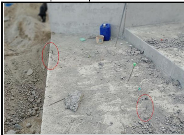
Fuente: Imagen n.º20 de acta de inspección física N°01-2025-CG/GRIC-SCC-PETACC Elaborado por: Comisión de Control
