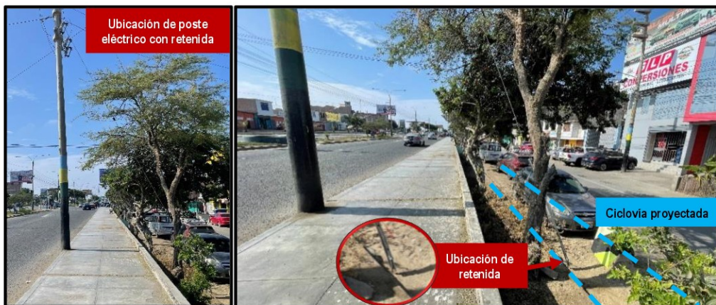
IMAGEN N° 10 PRESENCIA DE POSTE ELÉCTRICO CON RETENIDA (PROGRESIVA 0+580 KM)
