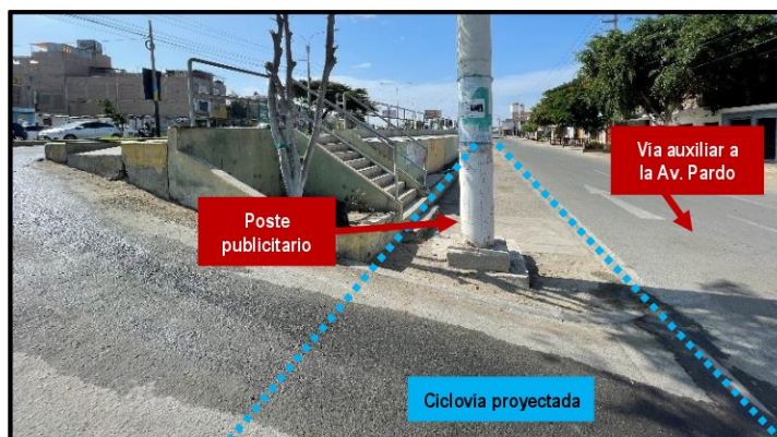
IMAGEN N° 6 PRESENCIA DE POSTE DE PANEL PUBLICITARIO (INTERSECCIÓN CON JR. CAHUIDE)
