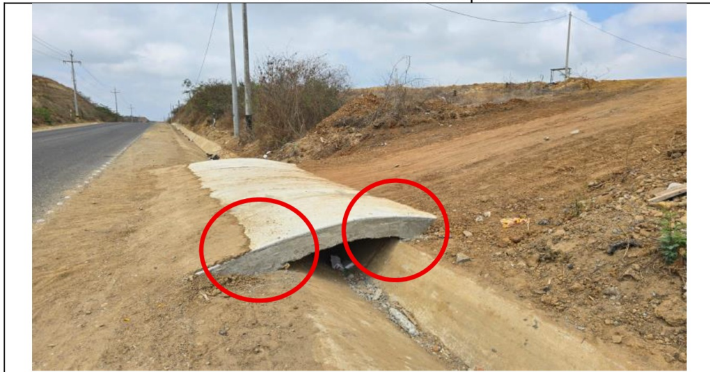
Registro fotográfico n.º 5: Pase vehicular construido en campo
