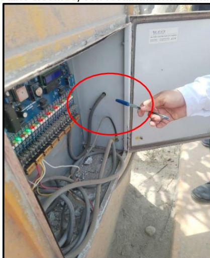
Imagen n.º 30 Cable eléctrico, con recubrimiento cortado
