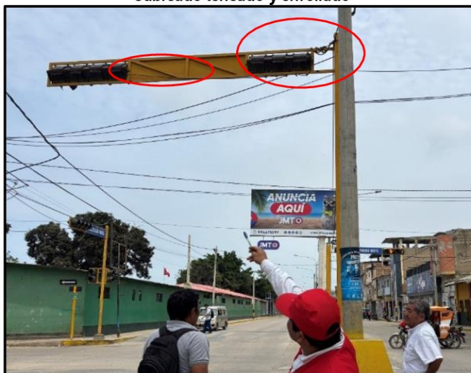
Imagen n.º 11 Cableado tensado y enrollado
