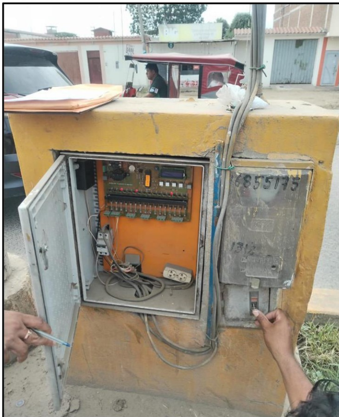
Imagen n.º 40 Cableado eléctrico de los semáforos, fue cambiado a aéreo.
