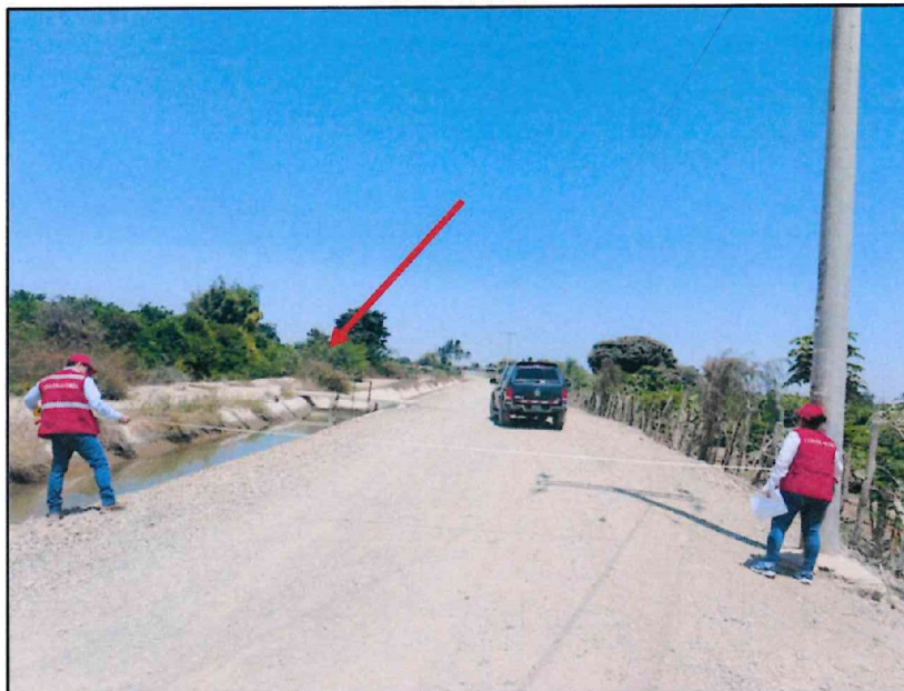
Fotografía n.º 8 Canal revestido
