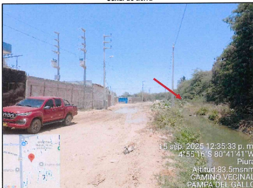
Fotografía n.º 9 Canal de tierra
