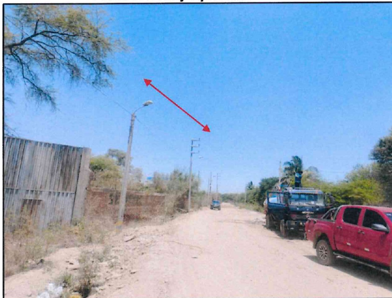
Fotografía n.° 10 Postes de media y baja tensión
