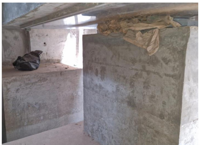
Fotografía n.º5.- Se visualiza cimentación y pedestales de aisladores, sin presencia de humedad – Área de piso técnico.
