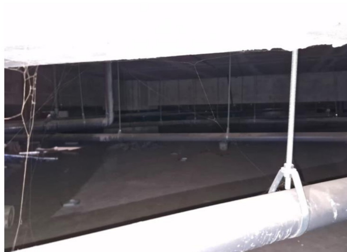
Fotografía n.º4.- Se visualiza cimentación y pedestales de aisladores, sin presencia de humedad – Área de piso técnico.
