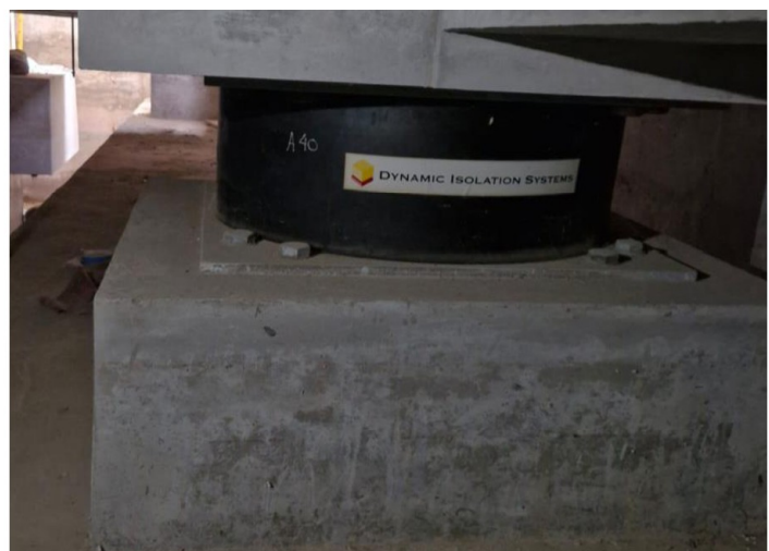
Fotografía n.º6.- Se visualiza cimentación y pedestales de aisladores, sin presencia de humedad – Área de piso técnico.
