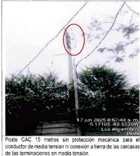
Poste CAC 15 metros sin protección mecánica para el conductor de media tensión ni conexión a tierra de las carcassas de las terminaciones en media tensión.
