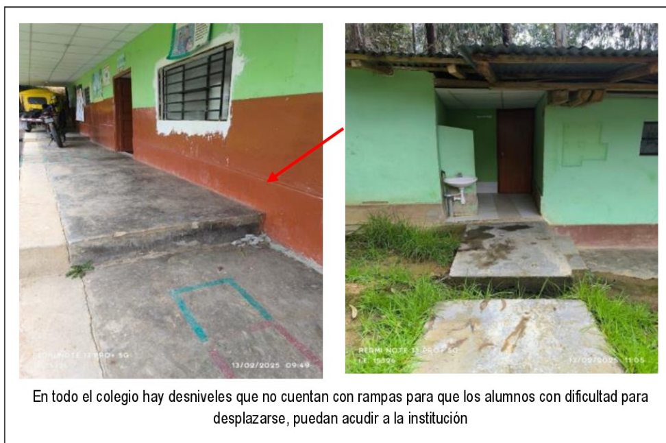
Imagen n.º 1 I.E. N° 15326 – Centro Poblado El Tambo – distrito y provincia de Huancabamba
