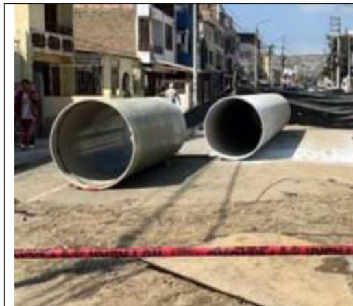
Imagen N° 3 Tubería en la vía pública en contacto con el suelo
