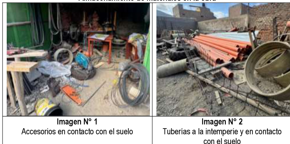
Imágenes N°s 1, 2, 3, 4, 5 y 6 Almacenamiento de materiales en la obra
