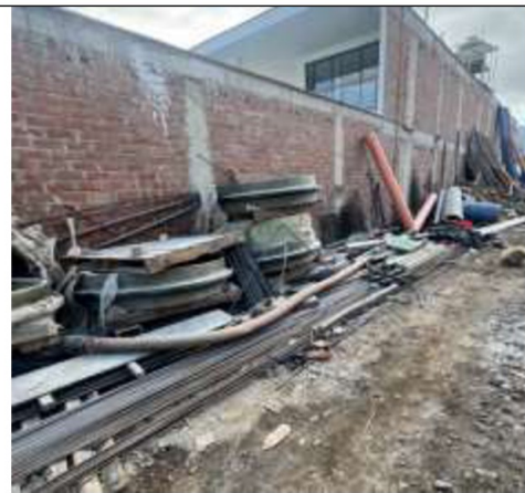
Imagen N° 4 Accesorios, tuberías y varillas de acero a la intemperie y en contacto con el suelo
