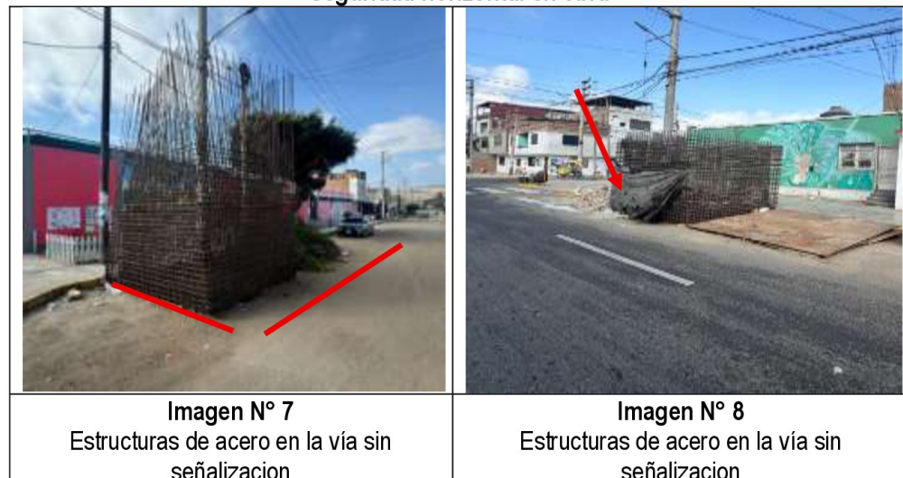
Imágenes N°s 7, 8, 9 y 10 Seguridad horizontal en obra
