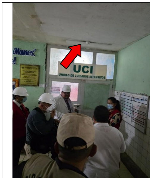
Fotografía N° 7: Hall de ingreso al ambiente destinado a la UCI en servicio, nótase la humedad en el cielo raso.
