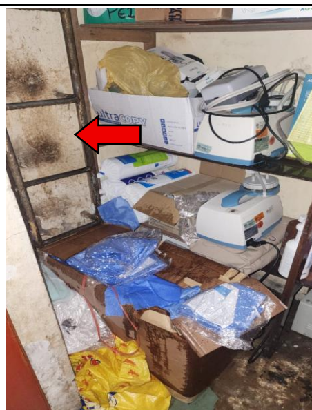
Fotografía N° 8: Depósito de materiales de la UCI, se observó humedad en pared por filtración de agua.
