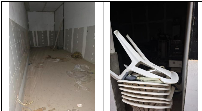
Fotografía N°s 24 y 25: Se han observado ambientes sin ventilación e iluminación natural, lo cual genera condiciones propicias para la acumulación de polvo y la proliferación de moho.
