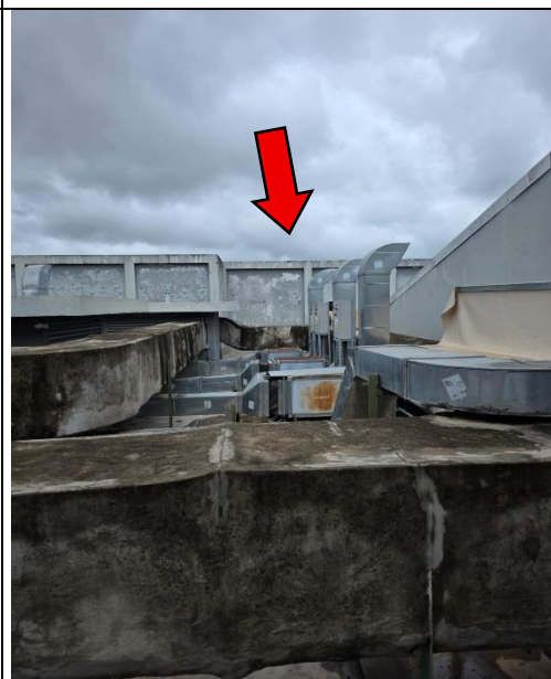
Fotografía N° 6: Azotea del pabellón "A" sin cobertura total y falta de mantenimiento, con tableros eléctricos expuestos sin cobertura de protección contra la lluvias y altas temperaturas del sol.
