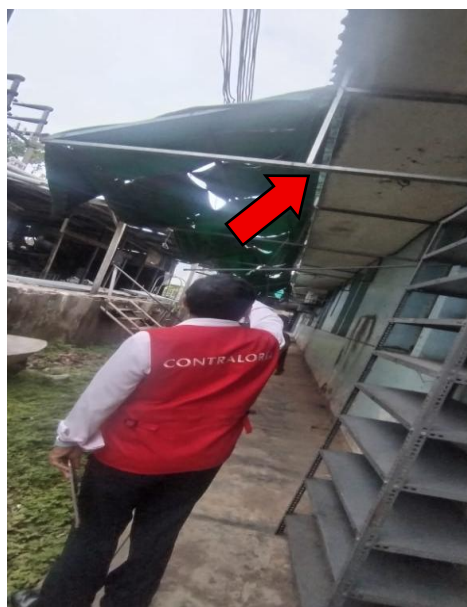
Fotografía N° 9: Parasoles desprendidos y deteriorados en la zona de ingreso a la UCI.
