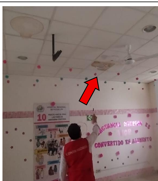
Fotografía N° 3: Cielo raso dañado a causa de la filtración de agua en el área de lactancia del tercer nivel del local nuevo; el ambiente no está siendo utilizado actualmente por dicha causa.
