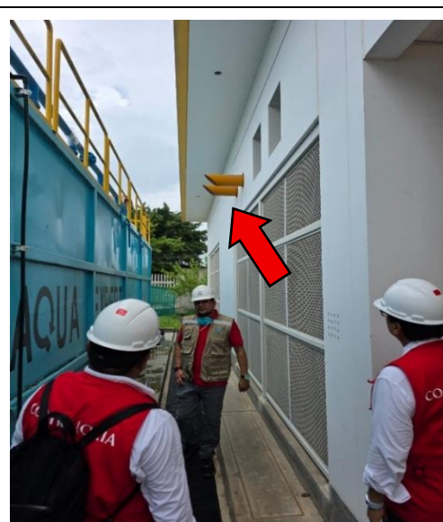
Fotografía N° 1: Toma de aire del sistema de oxígeno está muy próximo al PTAR, poniendo en riesgo de contaminación del oxígeno para el hospital.
