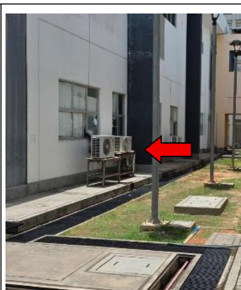
Fotografía N° 2: Equipos de aire acondicionado (condensadores) colocados sobre bancos de madera provisionales inestables.
