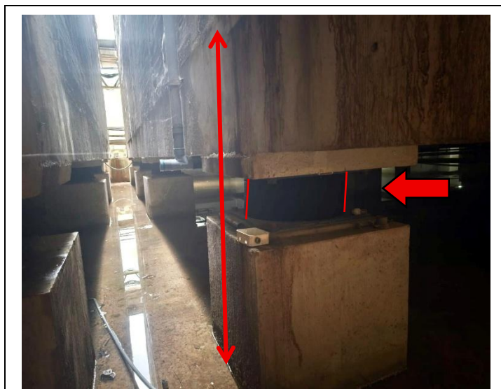
Fotografía N° 15: Nótese la deformación lateral de uno de los aisladores del sistema de aislamiento sísmico del hospital.
