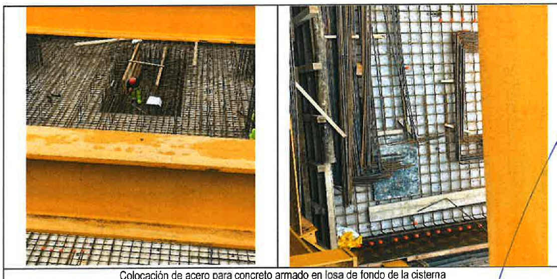
Colocación de acero para concreto armado en losa de fondo de la cisterna
