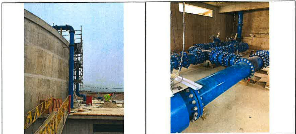
Trabajos de colocación de ladrillo pastelero y se observa tubería hidráulica instalada en caseta de válvulas
