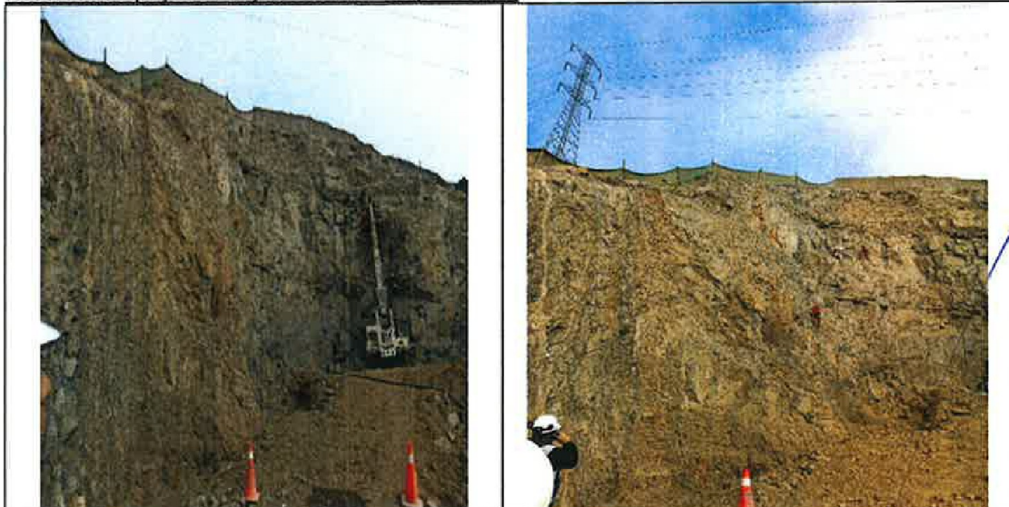
Ejecución partidas relacionadas al sostenimiento de taludes adyacentes al reservorio.
