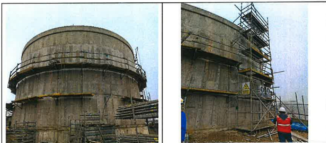
Ejecución partidas relacionadas a tratamiento y acabado exterior de muros de concreto armado del reservorio.
