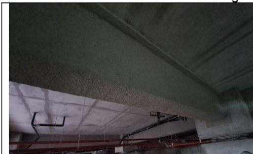
Imagen 8. Vista de recubrimiento de mortero en vigas reforzadas con fibra de carbono en Piso Técnico del Edificio Clínico.
