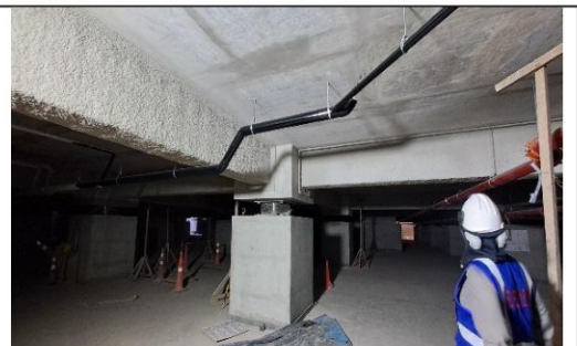
Imagen 9. Vista de recubrimiento de mortero en vigas reforzadas con fibra de carbono en Piso Técnico del Edificio Clínico.
