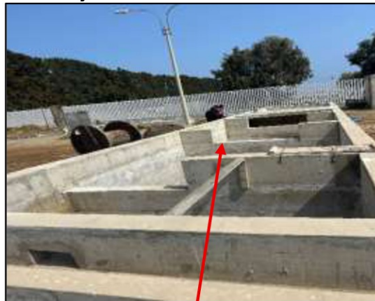
Infraestructura para almacenamiento de petróleo Diesel inconcluso y sin uso
