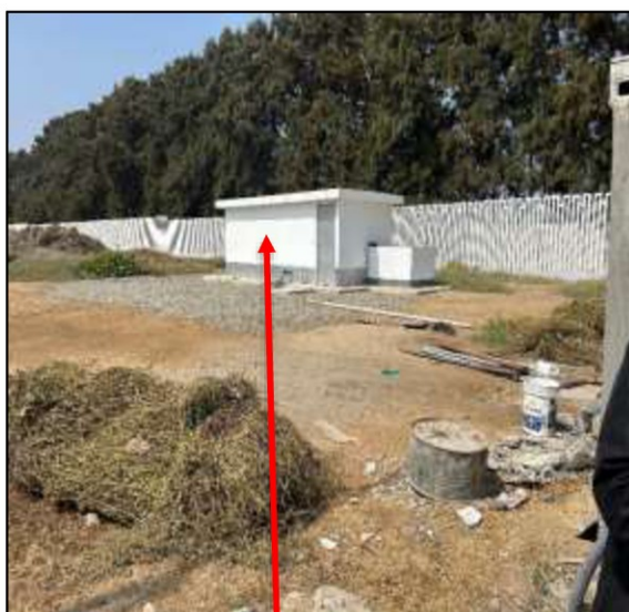
Caseta de captación de pozo perforado de agua
