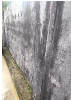
Pared en cerco presenta moho, manchas, con evidente daño a la pintura y al revestimiento, donde además se puede observar hasta crecimiento de vegetales en la base del muro.
