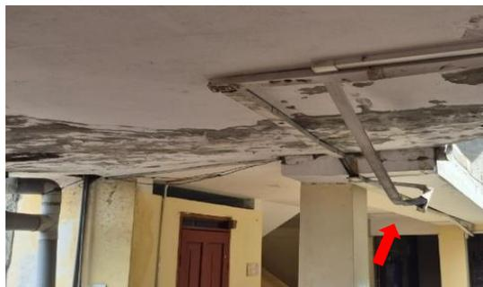
Cables eléctricos expuesto, sin protección mediante conductos, por lo que van colgando, mientras algunas canaletas se están desprendiendo del cielo raso.
