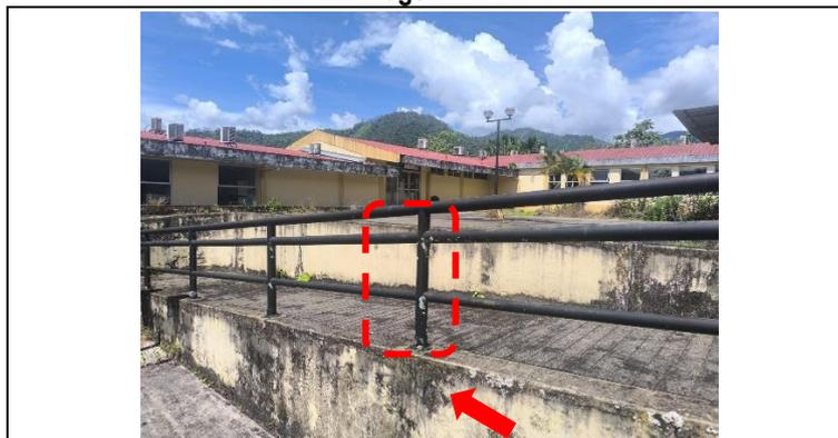
Imagen de la baranda con signos de oxidación y muros de la rampa con evidencia del deterioro de la pintura, y la presencia de humedad.
