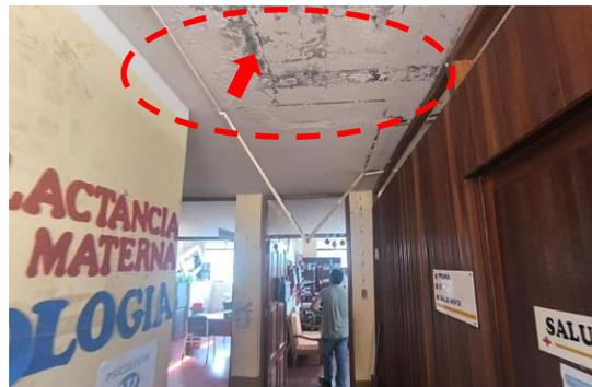
Deterioro de la pintura cielo raso, por presencia de humedad, por filtración de agua, en el que además se puede apreciar una grieta.
