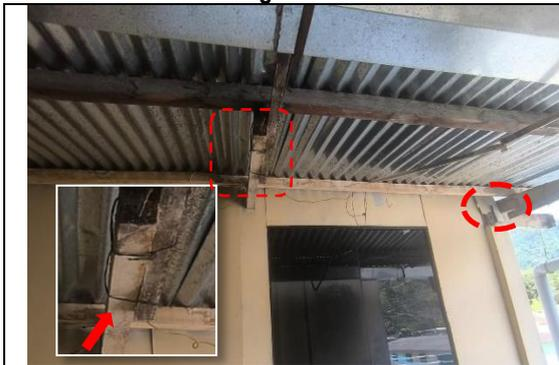
Cobertura de calamina, cuya estructura de soporte de madera, presenta empalme de vigas sujetado mediante alambre recocado, el mismo que presenta óxido, además, las maderas no presentan algún tipo de protección con pintura u otro.
