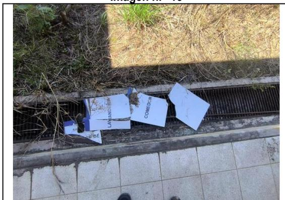
Canaleta de drenaje pluvial con material que obstruye su paso, y con presencia de material orgánico.
