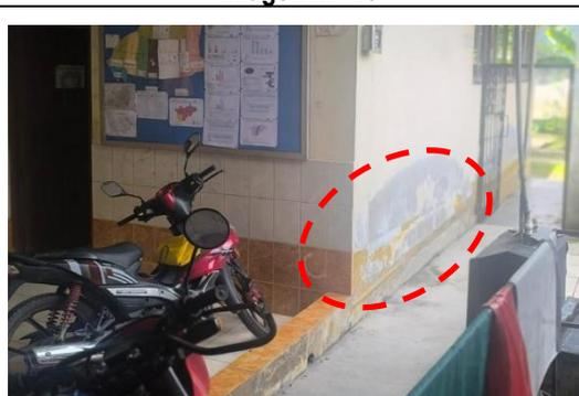
Desgaste de la pintura en la parte inferior de una pared exterior, debido a los efectos de las lluvias, donde ya se puede apreciar directamente el revestimiento de mortero.
