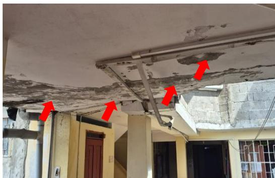
Desprendimiento de la pintura del cielo raso, con afectación del revestimiento, como efecto de la presencia de humedad por filtración de agua.
