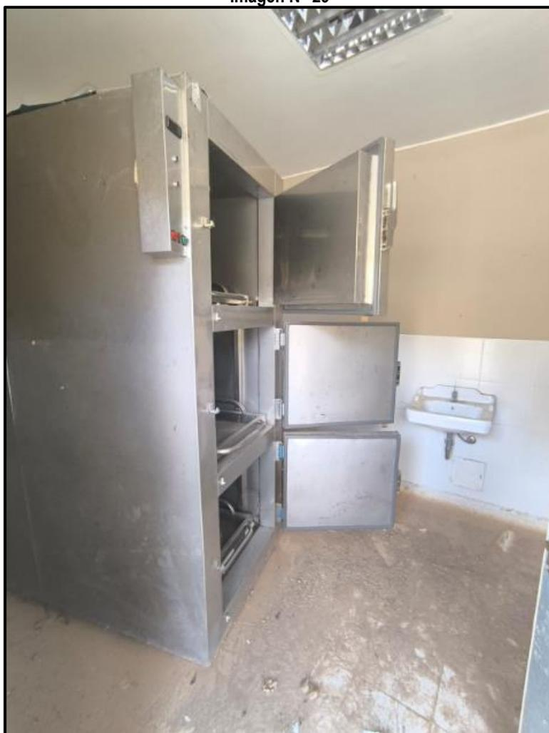
**Cámara de refrigeración:** en la imagen se puede observar el equipo en estado de deterioro por la falta de uso y mantenimiento, asimismo presencia de suciedad.
