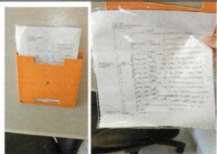
Vista de diagrama unifilar de tablero TCR-109, no se observa la descripción de los circuitos de reserva y DPS.
