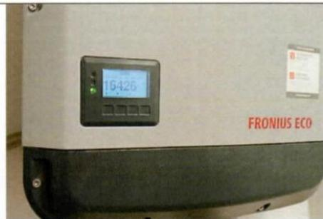
Vista de inversor a las 14:46 horas, alcanzó una potencia de 16.43KW
