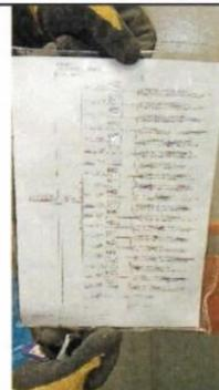
Vista de diagrama unifilar de tablero TCR-301, no se observa la descripción de los circuitos de reserva y DPS
