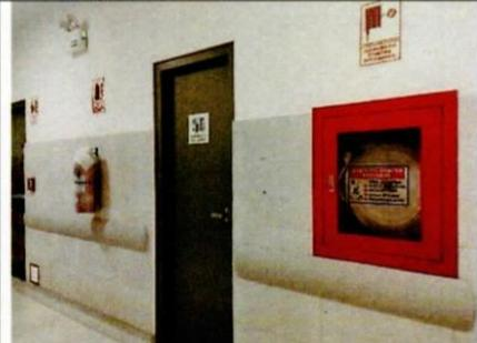
Vista de extintor adosado en muro y gabinete empotrado en corredor de circulación interior.
