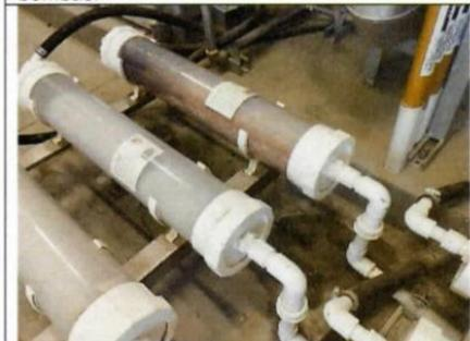
Vista de equipos instalados, donde se evidenció que se filtró el líquido debajo de un equipo.
