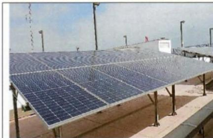
Los paneles solares se encuentran cubiertos de una capa de polvo
