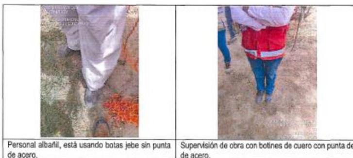
Fotografías N° 36, 37: Uso de EPP- Protección de los pies
