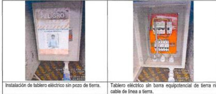
Fotografías N° 38,39: Instalación de tablero eléctrico.
