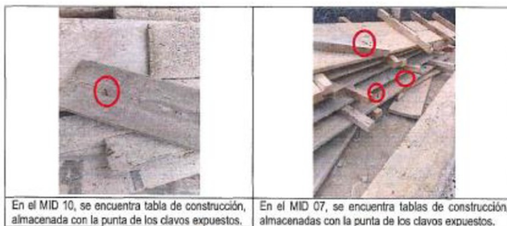
Fotografías N° 32, 33: Tablas de madera con la punta de clavos expuestos
