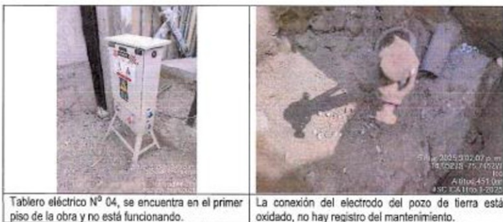
Fotografías N° 06, 07: Tablero eléctrico N° 04 y pozo de tierra
