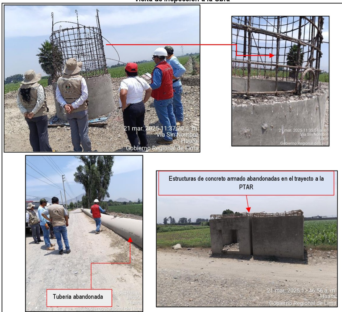
Imágenes 23, 24, 25 y 26 Visita de inspección a la Obra
