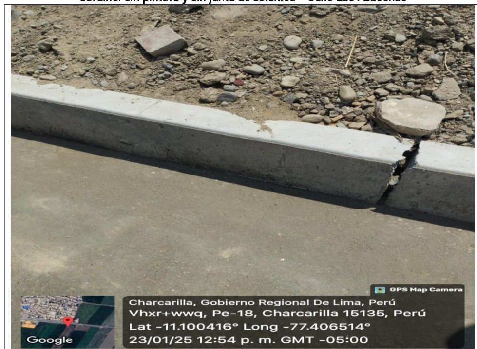
Sardinel sin pintura y sin junta de asfáltica – Calle Las Azucenas
