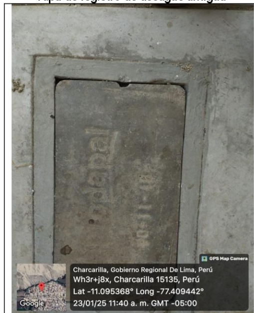
Imagen n.º 26 Tapa de registro de desagüe antigua
