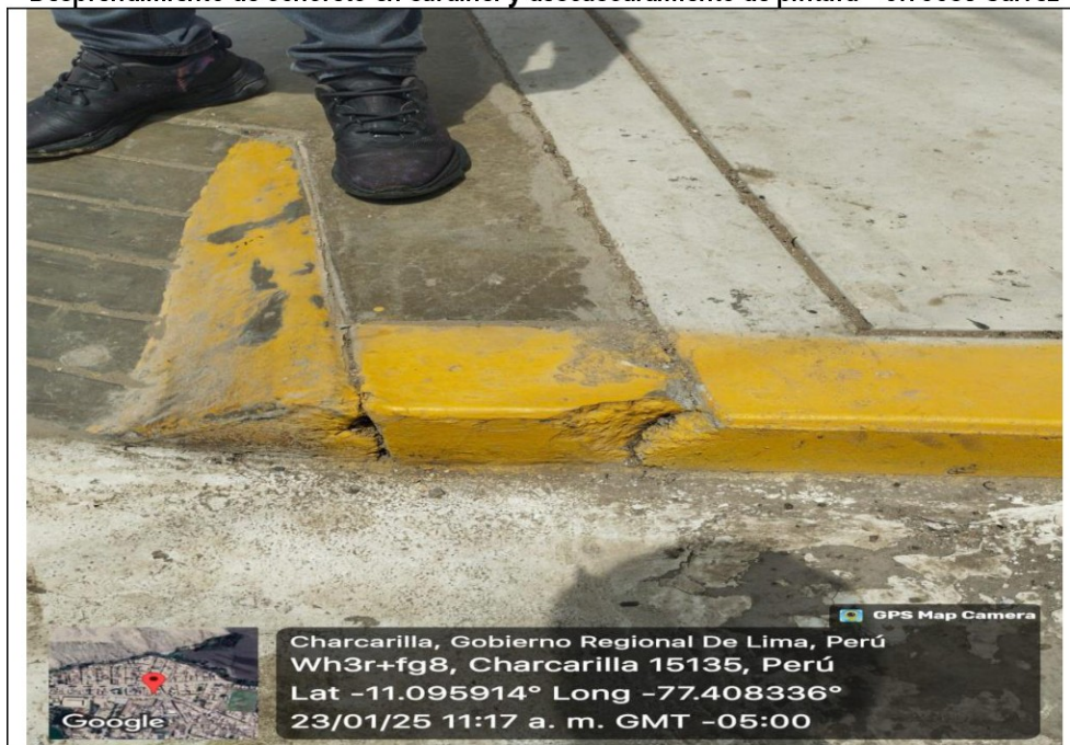
Imagen n.º 05 Desprendimiento de concreto en sardinel y descascaramiento de pintura – Jr. José Gálvez
