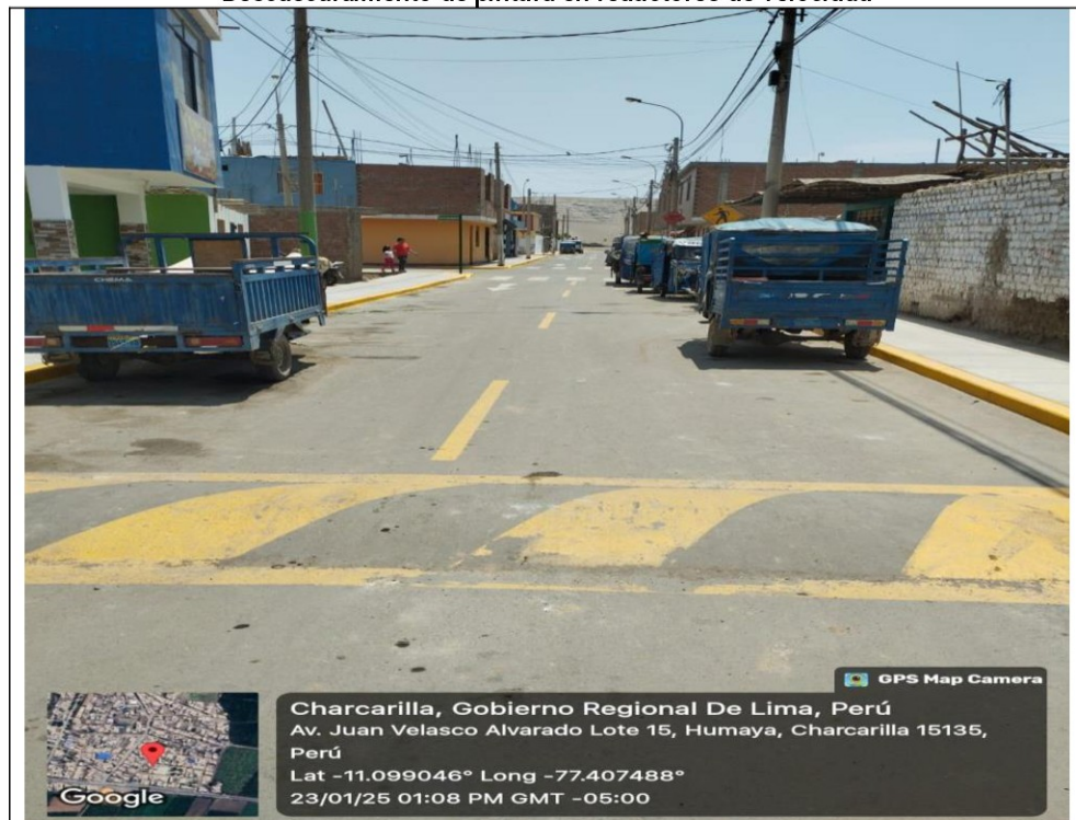
Imagen n.º 14 Descascaramiento de pintura en reductores de velocidad
