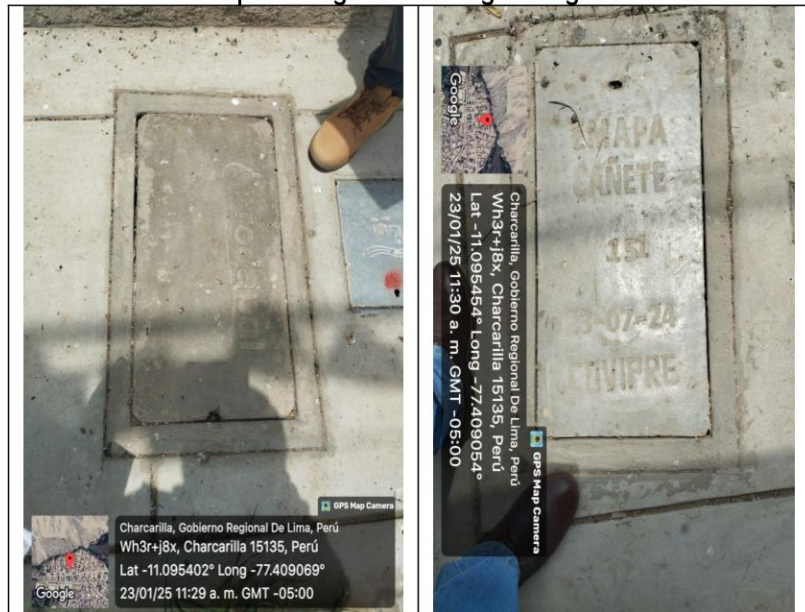
Imágenes n.º 24 y 25 Tapas de registro de desagüe antiguas
