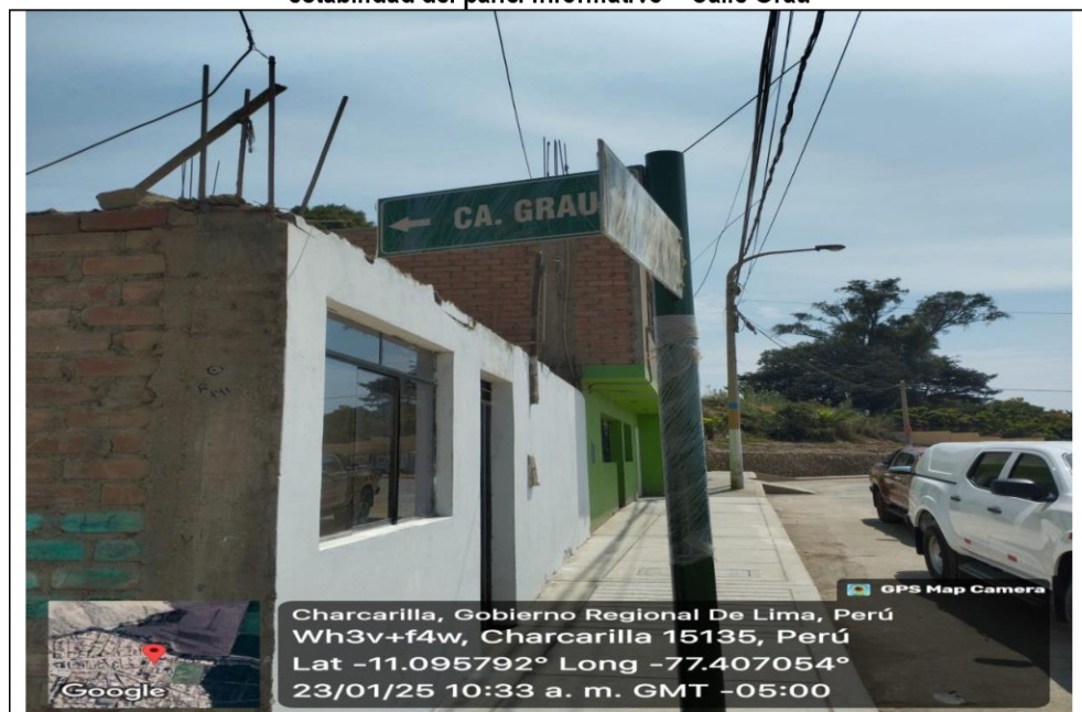
Imagen n.º 16 Señalización vertical se encuentra sin el suficiente aseguramiento para mantener la estabilidad del panel informativo – Calle Grau
