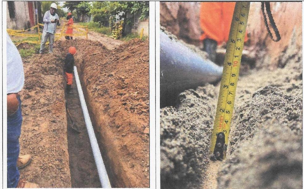
**Vista n.° 1:** Proceso de instalación de tuberías de distribución de agua, sobre un encamado insuficiente en nivelación y espesor de cama de arena.
