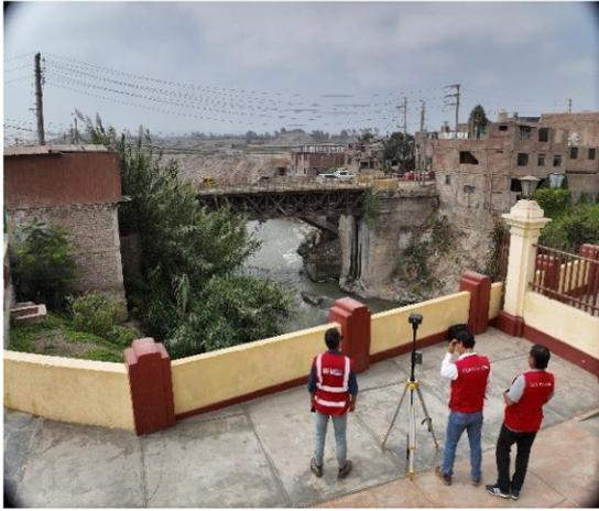
**Vista n.º 8:** Comisión de control instalando el GPS para vuelo del Drone, con fines de realizar la fotogrametría del puente ubicado en el río Huaura.
