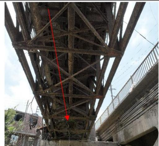
**Imagen n.º 46:** Puente peatonal con presencia en toda su estructura de corrosión, además de estar adosada a su estructura tubería de hierro de 6" aproximadamente.
