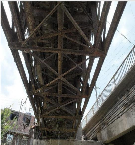
**Vista n.º 5:** Vista de la parte inferior del Puente peatonal ubicado en el río Huaura, presenta corrosión en toda su estructura, además la presencia de tuberías, en muy estado.
