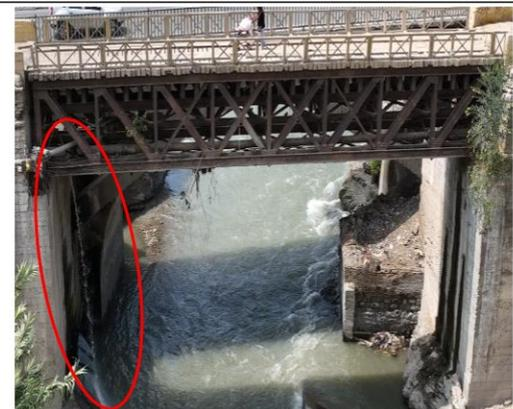
**Imagen n.º 48:** vista panorámica del puente peatonal, presenta corrosión en toda su estructura, además de presentar tubería que descarga su caudal directamente a la cimentación del puente.
