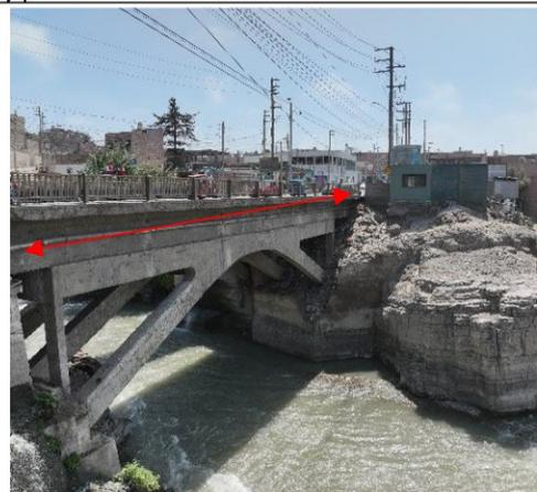
**Imagen n.º 43:** vista panorámica del puente vehicular, el cual presenta una tubería adosada mediante ganchos de acero a su estructura, el cual atraviesa toda la longitud del puente vehicular.
