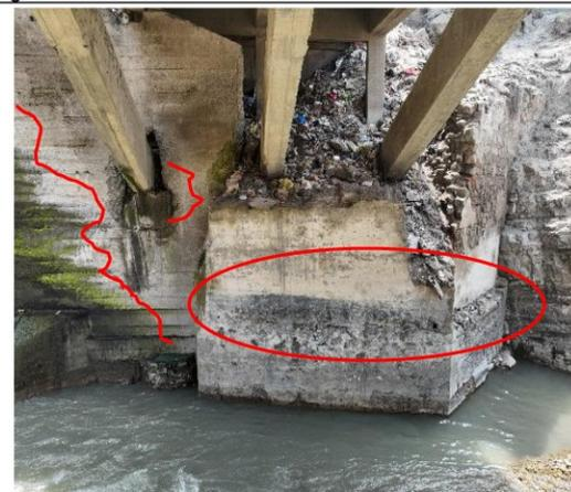
**Imagen n.º 44:** Cimentación del puente vehicular, presenta fisuras, desgaste en su estructura, y humedad puesto que la misma se encuentra en contacto directo con el caudal del río Huaura.
