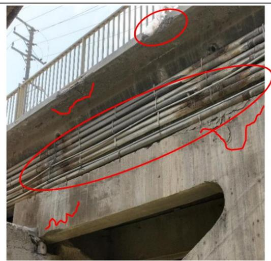
**Imagen n.º 42:** Puente Vehicular presenta fisuras, desprendimiento de concreto dejando expuesto el acero de refuerzo, además de presentar tuberías adosadas con ganchos a su estructura.
