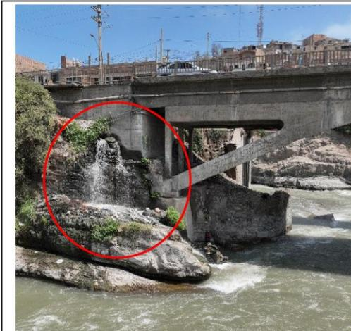
**Imagen n.º 45:** En los estribo del puente vehicular, se aprecia tuberías de desagüe que descarga directamente a la cimentación del puente, hecho que viene debilitando su estructura.
