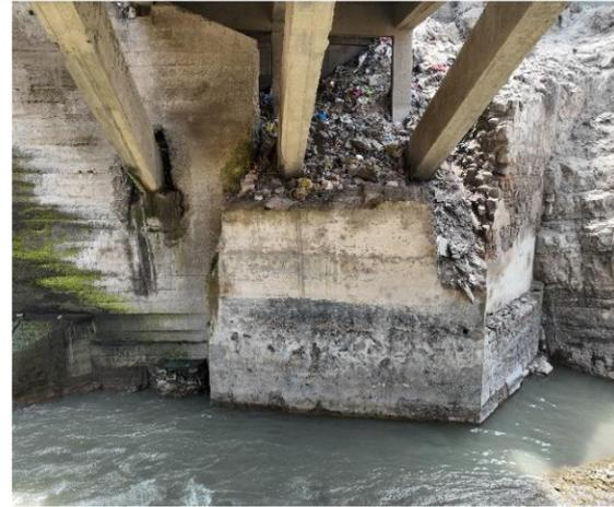
**Vista n.º 9:** Estribo de puente ubicado en el río Huaura, se encuentra deteriorado, además de presentar fisuras en la estructura del puente.
