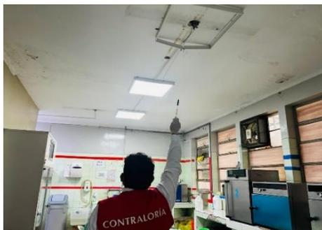
Techos con humedad, falta de luminaria y cables expuestos traen como consecuencia falta de iluminación en las zonas denominadas rojo y azul de la Central de Esterilización.
