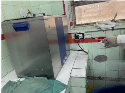
Proximidad de la lavadora (desinfección enzimática) con el tomacorriente de luz y exposición de cables traería como consecuencia un potencial riesgo de electrocutamiento al personal asistencial de dicho servicio de esterilización.
