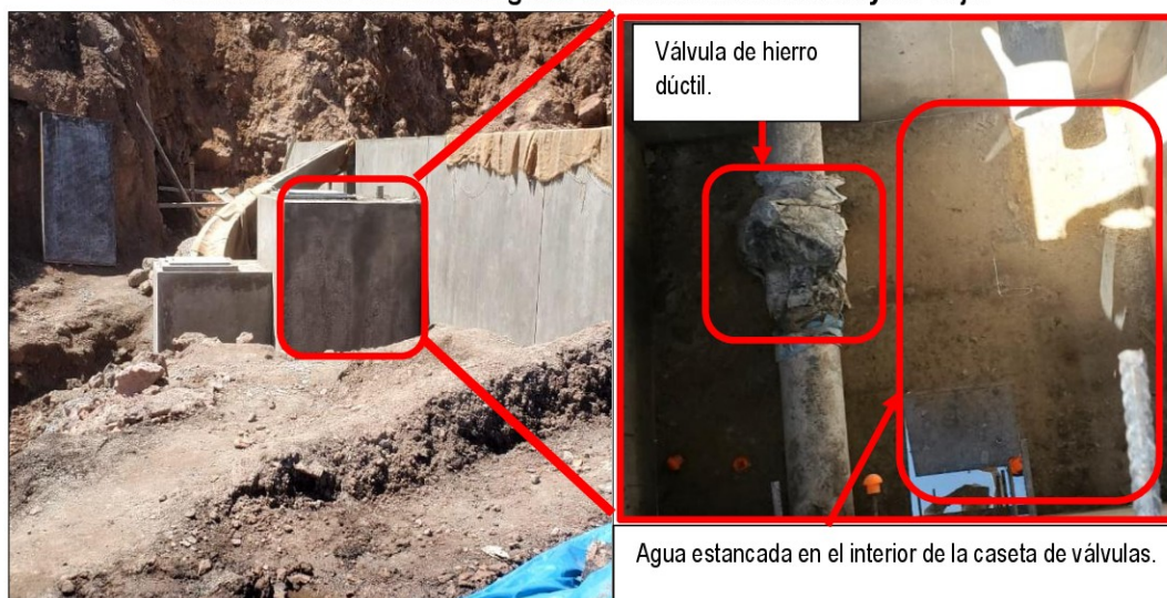
Imagen n.º 6 Construcción de cámara de ingreso del reservorio de Huancayocc Baja.
