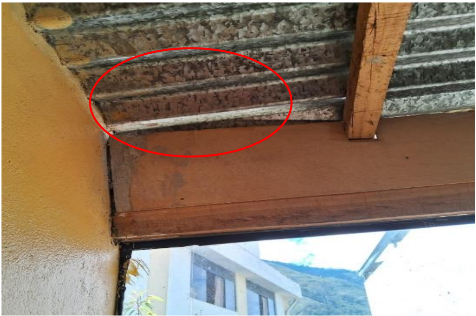
Toma Fotográfica n.º 16: Existencia de aberturas no selladas en el techo del almacén que podría dar paso a roedores e insectos.
