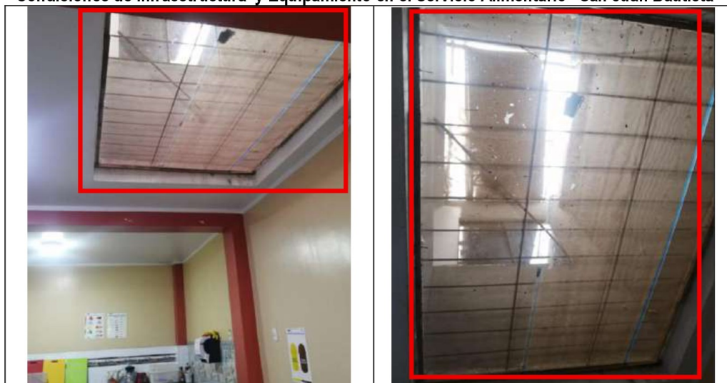
Fotografías n.ºs 49 y 50: Techo traslúcido no está en buen estado de conservación, con acumulación de suciedad en el área de preparación de alimentos
