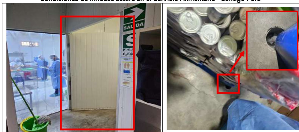
Fotografía n.º 61: Sumidero del piso no cuenta con rejilla que impida el anidamiento de insectos.
