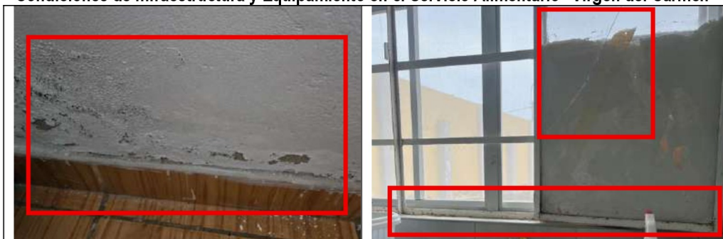
Fotografía n.º 42: Ventanas ubicadas en el área de cocina se encuentran con rajadura, y presencia de oxido.
