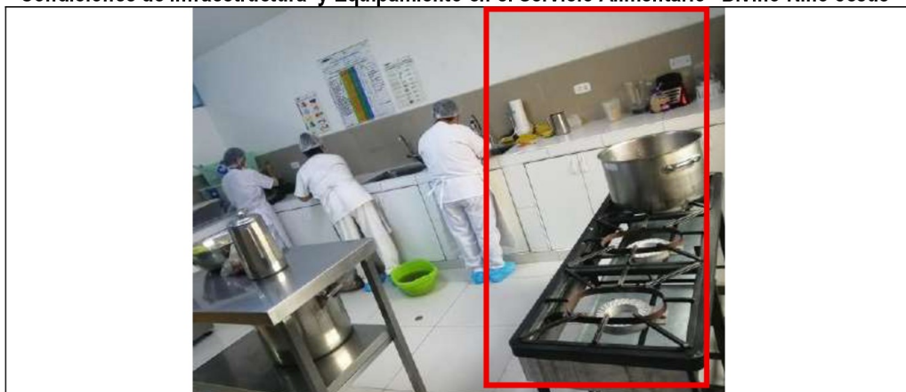
Fotografía n.º 46: El área de cocina no cuenta con campana extractora ni ducto.
