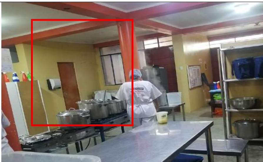
Fotografía n.º 51: El área de preparación de alimentos no cuenta con campana extractora y ducto para el equipo de cocina.
