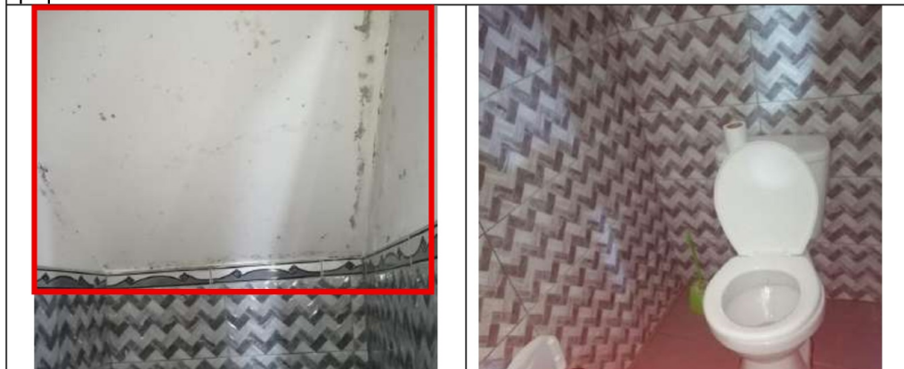
Fotografía n.º 58: Paredes con presencia de humedad en el servicio higiénico de las socias de cocina.
