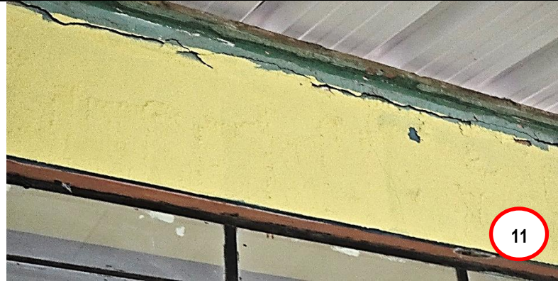
Fotografías n.ºs 9,10 y 11.- En la toma fotográfica se muestra que las paredes de las aulas presentan fisuras.
