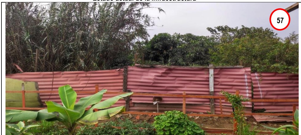
Panel fotográfico n.º 6 Estado actual de la infraestructura
