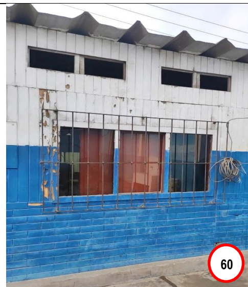
Fotografías n.ºs 59 y 60.- En las tomas fotográficas se evidencia que las paredes y los techos de algunas aulas requieren mantenimiento como resane y pintado de muros.
