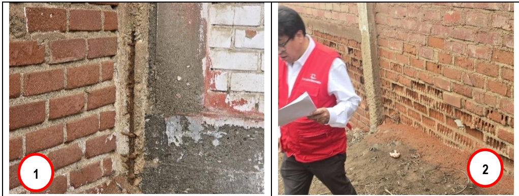
Panel fotográfico n.º 1 Estado actual de la infraestructura
