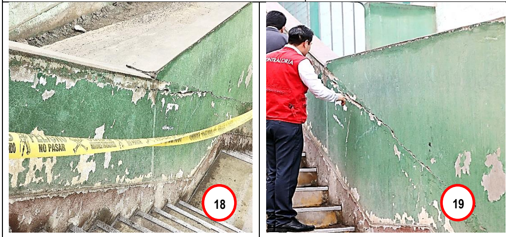
Fotografías n.ºs 12, 13, 14, 15, 16 y 17.- En las tomas fotográficas se evidencia la existencia de una falla estructural como consecuencia del último movimiento sísmico en la escalera del pabellón del nivel secundaria.
