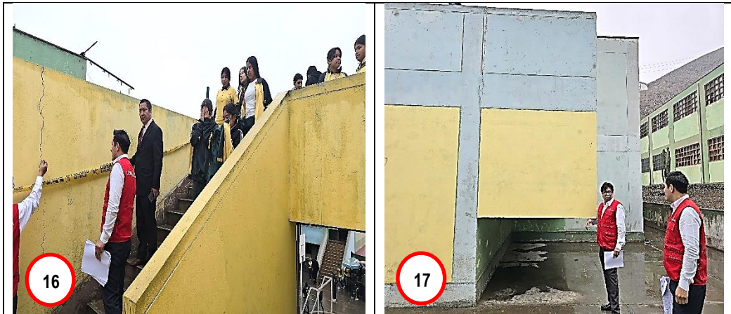
Fotografías n.ºs 12, 13, 14, 15, 16 y 17.- En las tomas fotográficas se evidencia la existencia de una falla estructural como consecuencia del último movimiento sísmico en la escalera del pabellón del nivel secundaria.
