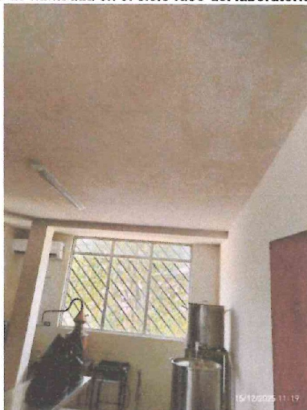
Imagen n.º 26 Manchas de humedad en el cielo raso del laboratorio de vinos
