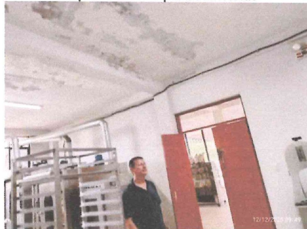
Imagen n.º 3 Desprendimiento de pintura en el techo
