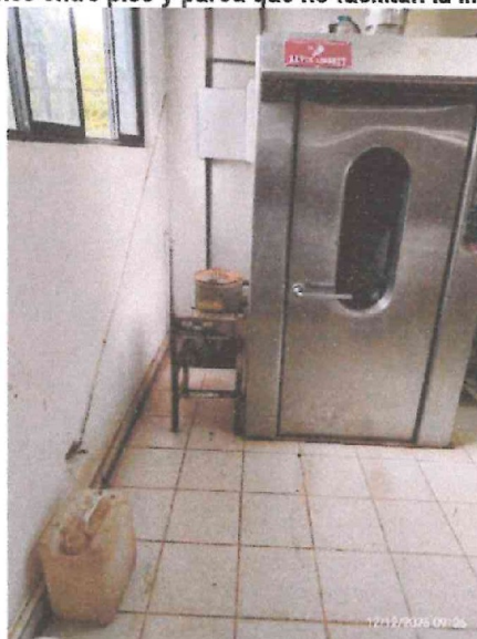
Imagen n.º 5 Uniones entre piso y pared que no facilitan la limpieza
