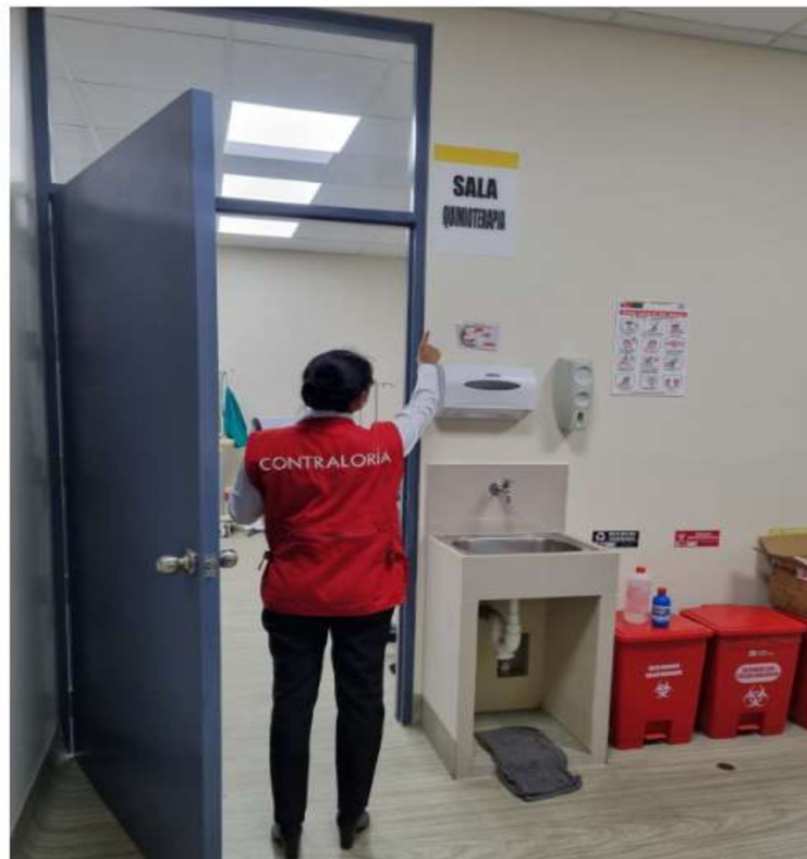
Fotografía n.º 5 Sala de Quimioterapia inoperativa
