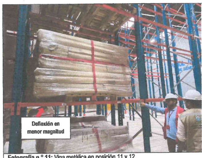
Fotografía n.º 11: Viga metálica en posición 11 y 12.
