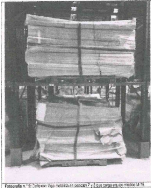
Fotografía n.º 9: Deflexión Viga metálica en posición 7 y 8 que carga equipo médico M-75
