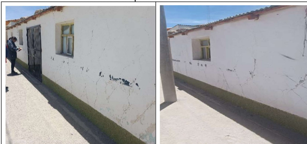
Fotografía n.º 1: Fisuras en muro del ambiente complementario.
