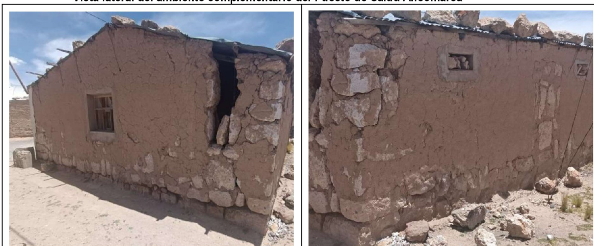
Fotografía n.º 3: Muro lateral presenta fisuras, desprendimiento del mortero y las unidades del muro lateral.
