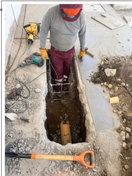
Imagen n.º 3: Demolición de caja de desagüe en nivel secundario
