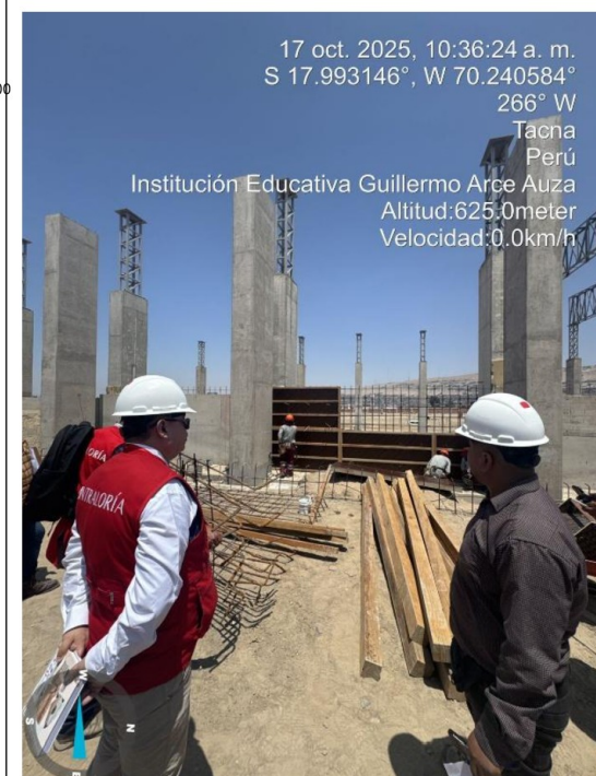
Imagen n.º 11: Verificación del encofrado de muros armados en zona de losa deportiva.
