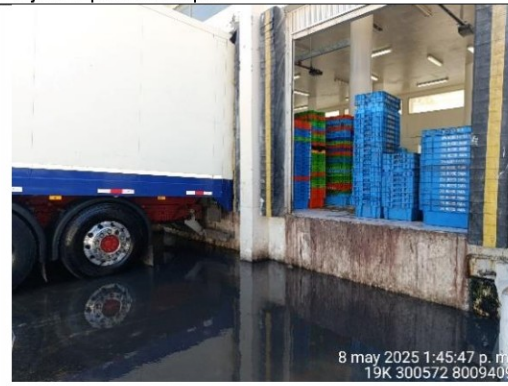
Fotografía n.º 34: Vista de camión frigorífico conectado a la puerta de embarque.
