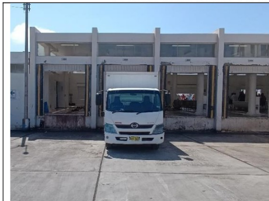
Fotografía n.º 31: Vista de patio de maniobras y puertas de embarque.
