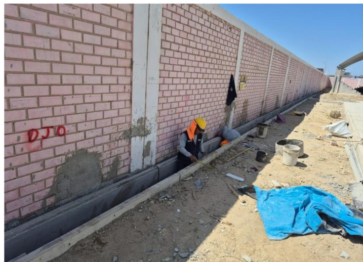
Fotografía n.º6.- Se visualiza la construcción de 16 paños de cuneta pluvial, sin considerar junta de separación.
