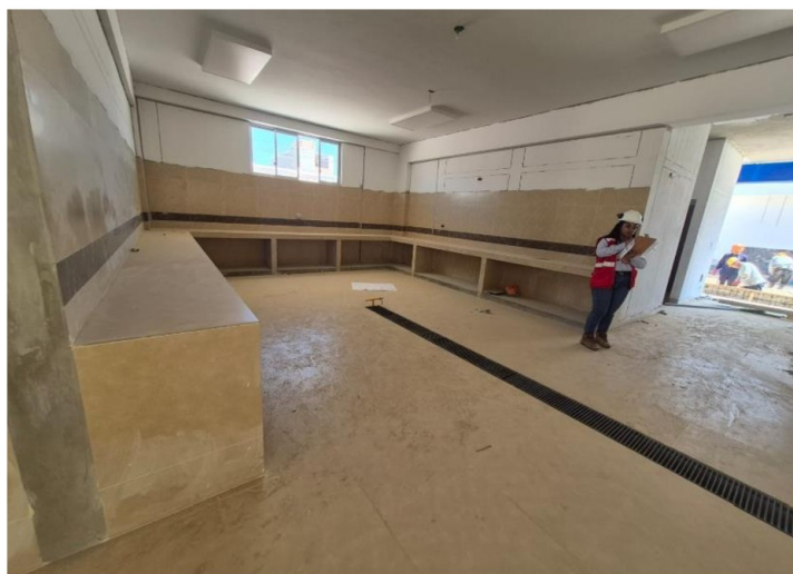
Fotografía n.º10. - Vista interior de pabellón 16 "Cocina y comedor".
