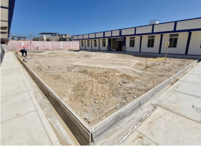
Fotografía n.º1.- Vista panorámica del exterior del bloque 18 y frentis del bloque 17.
