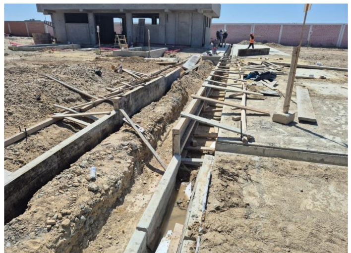
Fotografía n.º12.- Se visualiza encofrado de cunetas.
