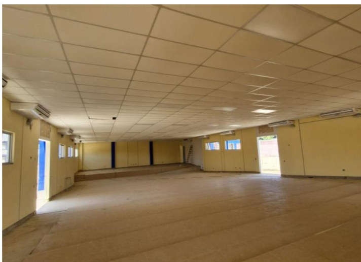
Fotografía n.º9. - Vista interior del pabellón 15 "Bloque SUM".
