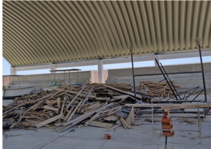
Fotografía n.º4.- Almacén de madera en patio techado.
