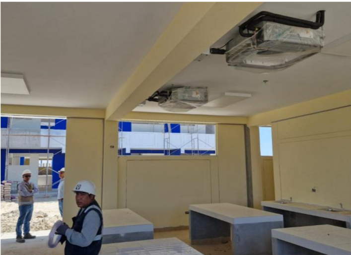
Fotografía n.º9.- Vista de la instalación de aires acondicionados en pabellón 11 y 12.
