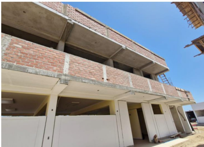
Fotografía n.º7. - Vista del frontis de bloque 10.
