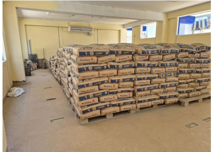
Fotografía n.º8.- Vista del apilado de bolsas de cemento en pabellón valorizado, sin protección en el piso.
