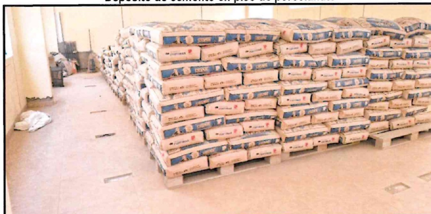
Fotografía n.º 8 Depósito de cemento en piso de porcelanato
