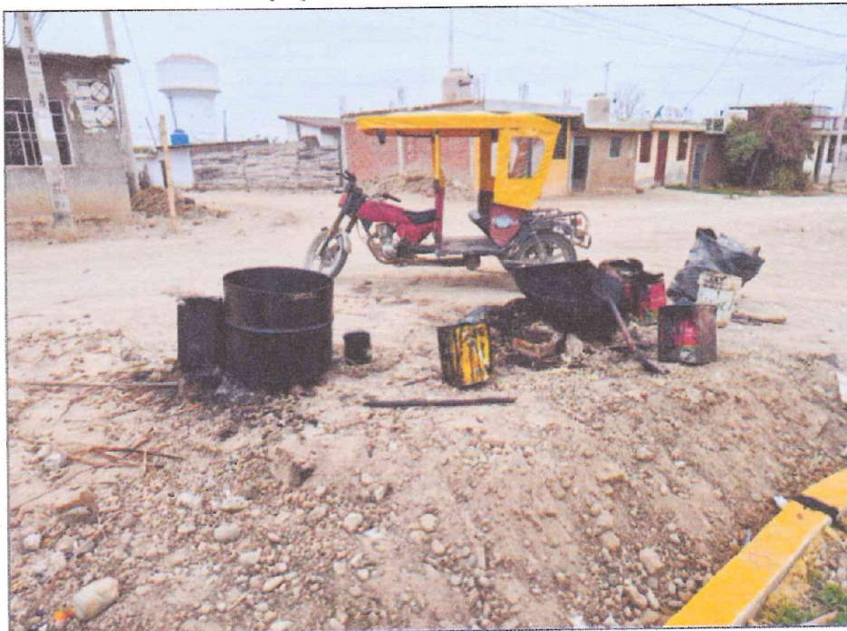
Fotografía n.º 14 Se evidencia preparación de mezcla asfáltica para juntas
