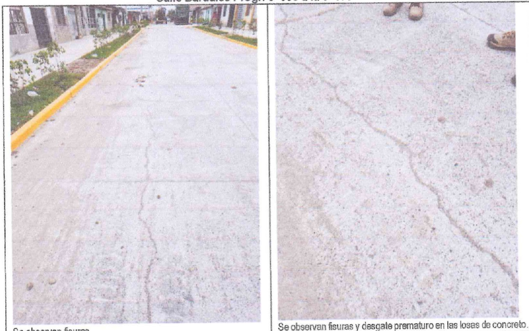
Fotografías n.ºs 1 y 2 Calle Bardales Progr. 0+000 a la 0+170
