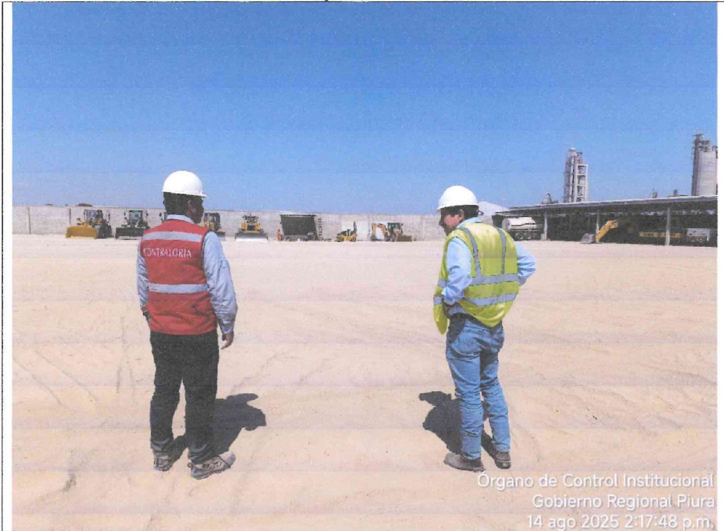
Patio de máquinas del Contratista.
