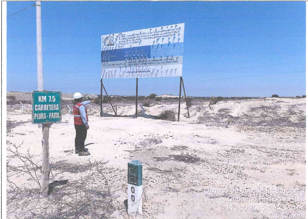
Panel fotográfico n.º 1 Estado situacional de la Obra.
