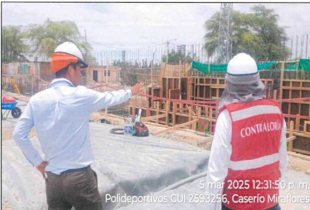
**Fotografía n.º 2: Verificación de avance - encofrado de graderías.**
