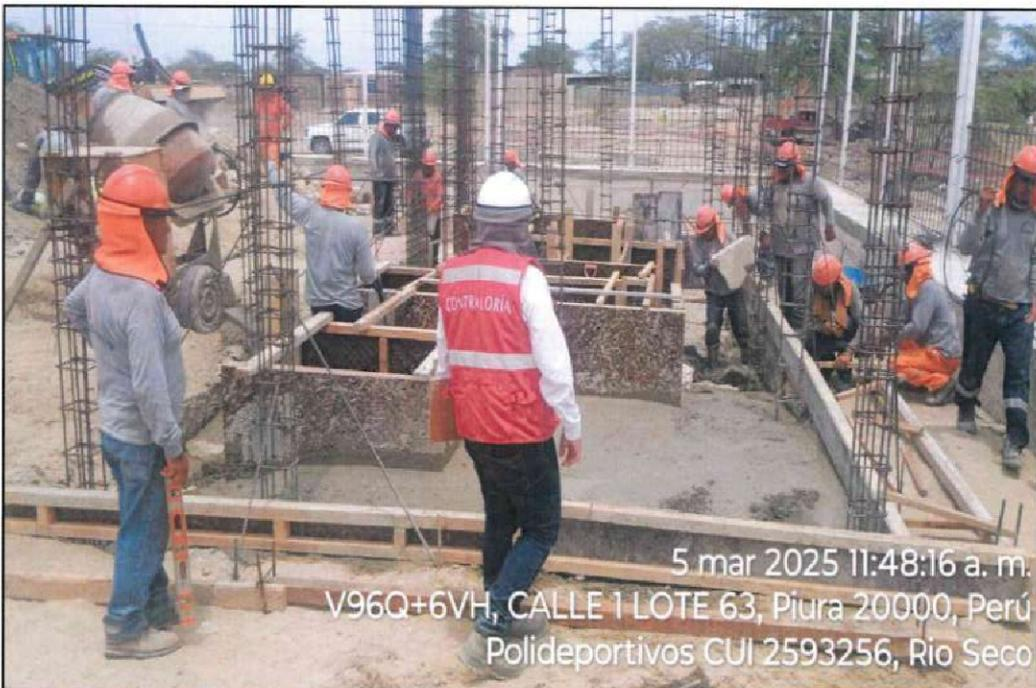
Fotografía n.º 8: Inspección de vaciado de concreto, cimentación batería de baños
