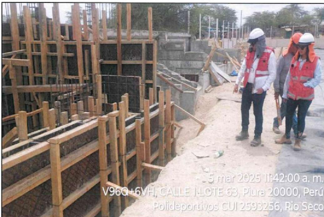
*Fotografía n.º 4: Inspección de estructuras correspondientes a graderías.*
