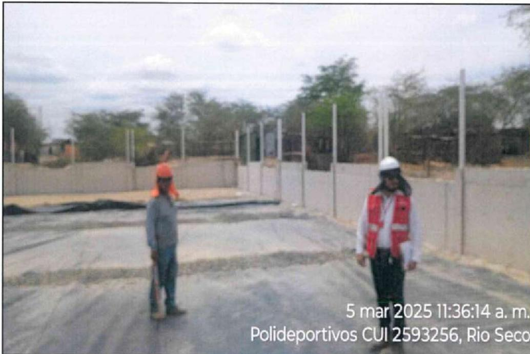
*Fotografía n.º 2: Colocación de geomembrana para cancha deportiva.*
