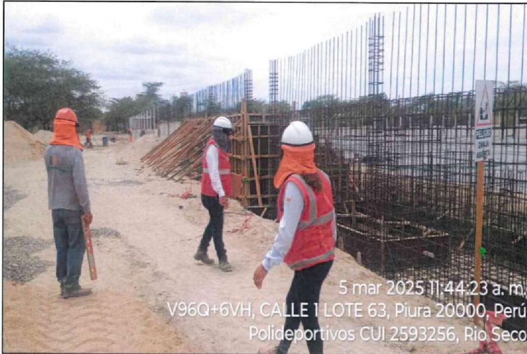
Fotografía n.º 7: Habilitación y colocación de acero para graderías.
