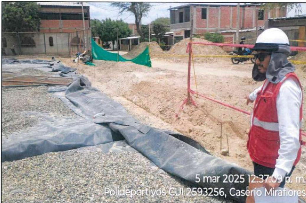
*Fotografía n.º 4: Verificación de colocación de geomembrana y esparcimiento de grava para cancha deportiva.*
