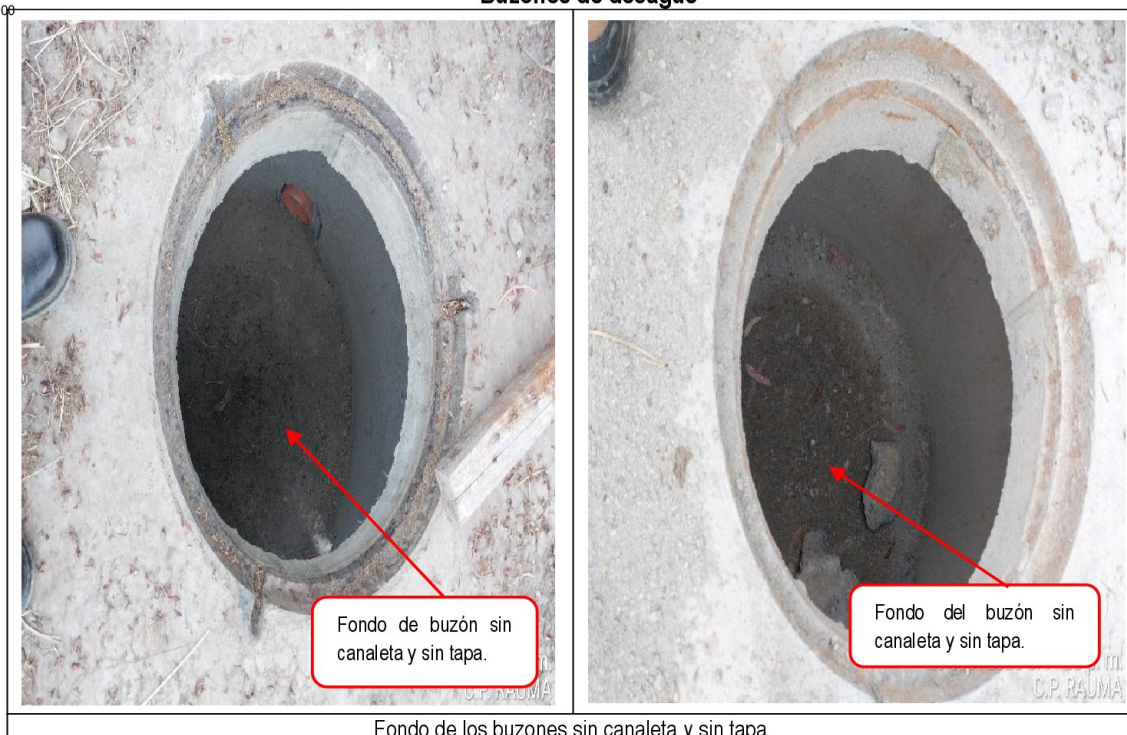
Imagen n.º 11 Buzones de desagüe
