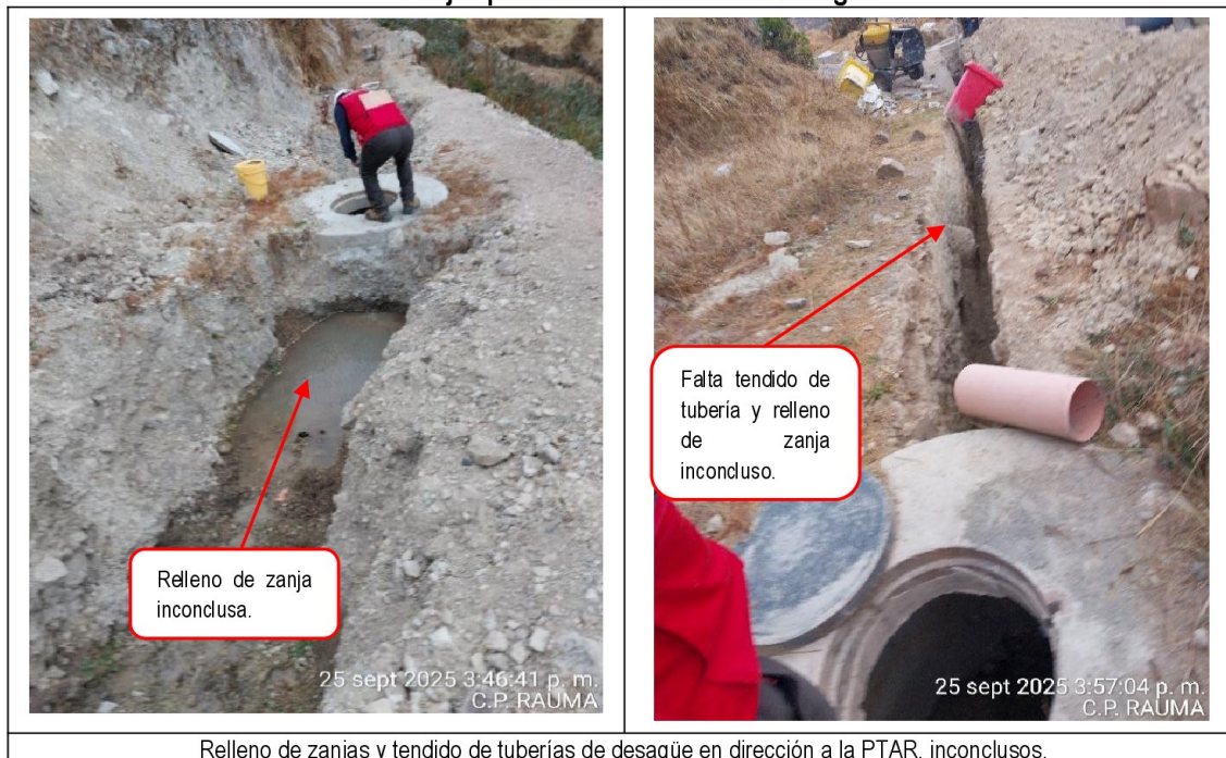
Imagen n.º 12 Zanjas por tendido de tubería de desagüe
