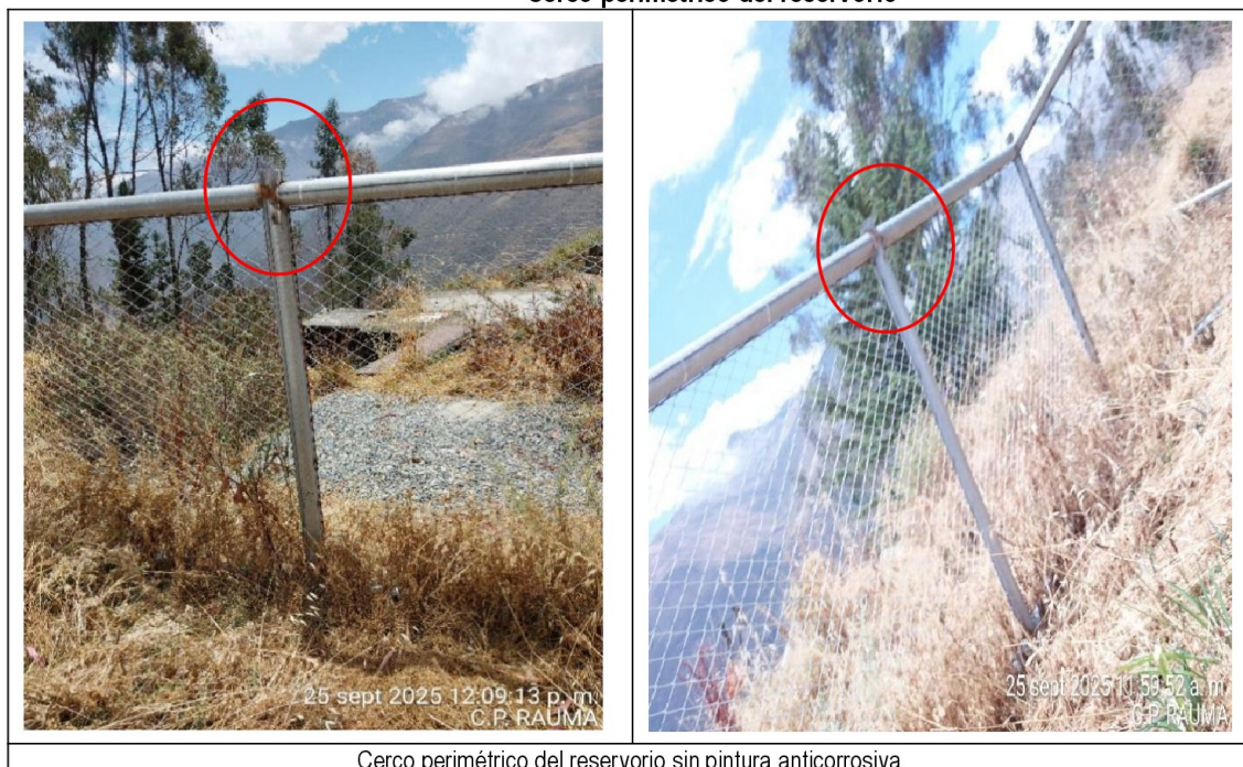
Imagen n.º 8 Cerco perimétrico del reservorio
