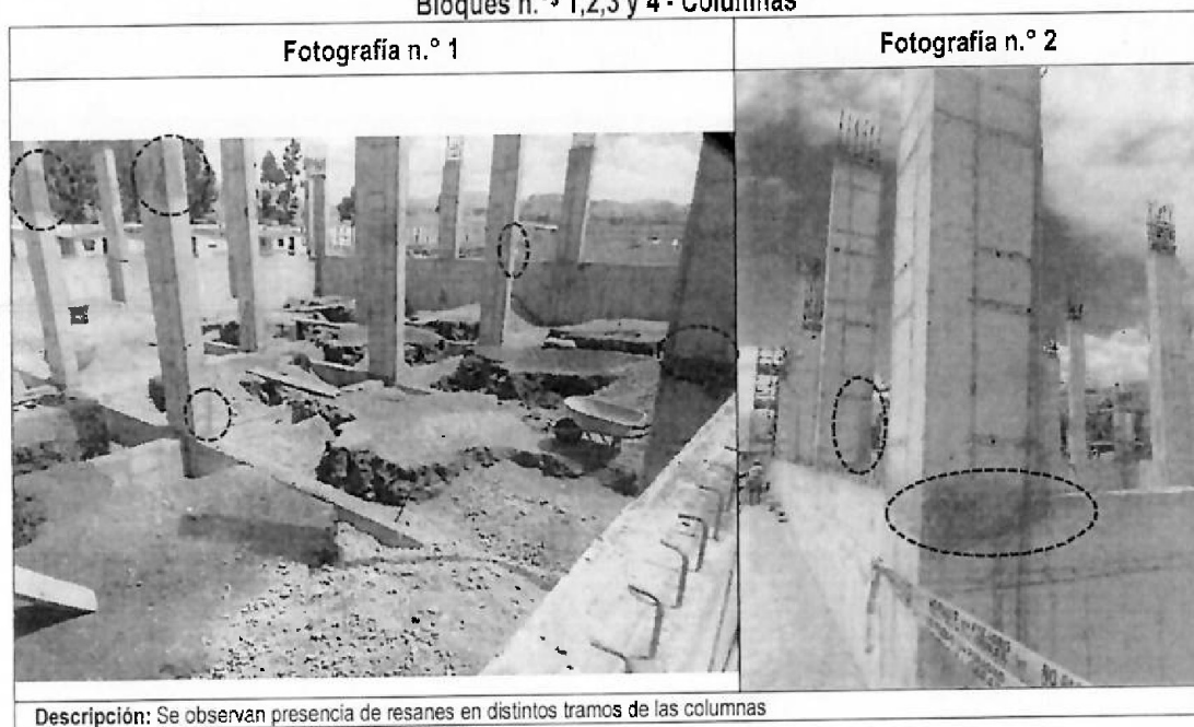
Fotografías n.ºs 1 y 2 Bloques n.ºs 1,2,3 y 4 - Columnas
