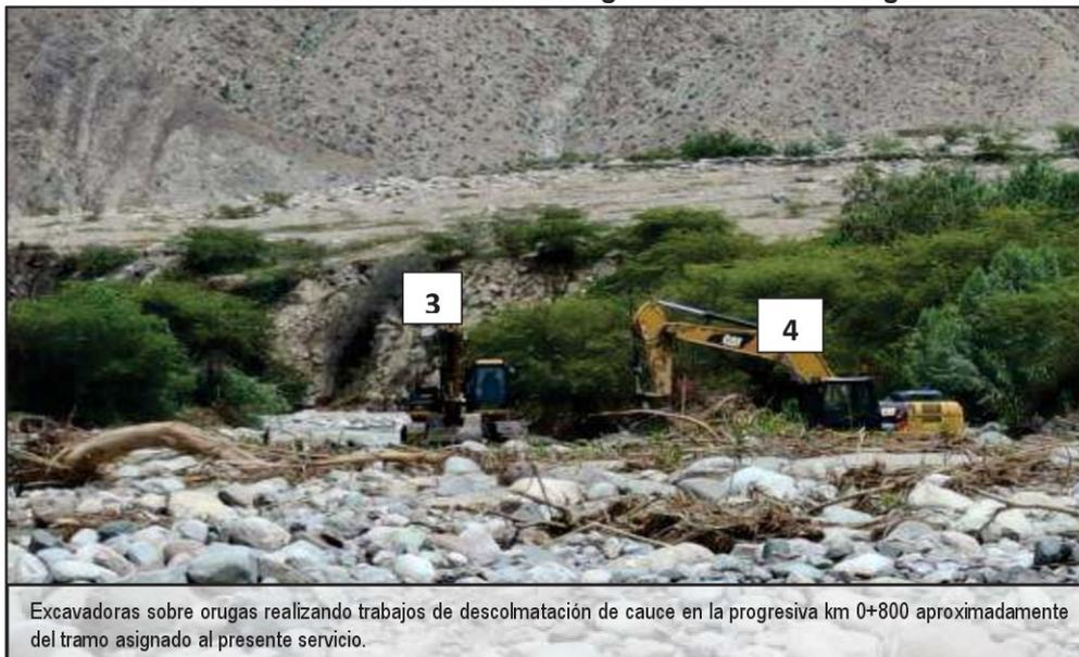
Excavadoras sobre orugas realizando trabajos de descolmatación de cauce en la progresiva km 0+800 aproximadamente del tramo asignado al presente servicio.
