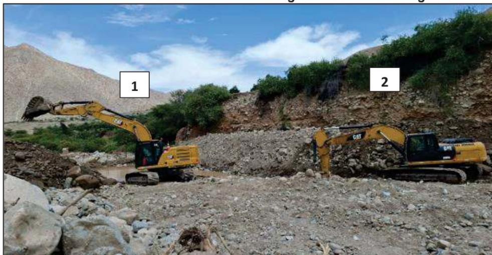
Excavadoras sobre orugas realizando trabajos de conformación de diques en la progresiva km 0+800 aproximadamente del tramo asignado al presente servicio.
