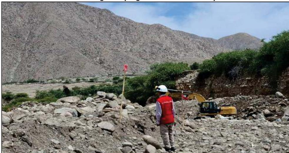
Excavadora sobre orugas realizando trabajos de descolmatación de cauce en la progresiva 0+800 aproximadamente del tramo asignado al presente servicio.
