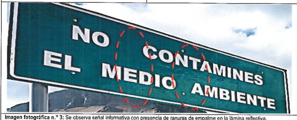
Imagen fotográfica n.º 3: Se observa señal informativa con presencia de ranuras de empalme en la lámina reflectiva.
