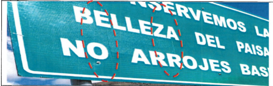
Imagen fotográfica n.º 5: Se observa señal informativa con presencia de ranuras de empalme en la lámina reflectiva.
