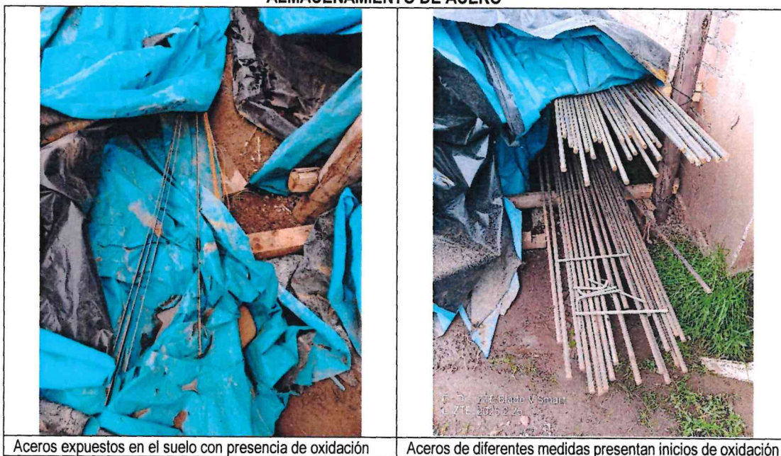
Imagen n.º 18 y 19 ALMACENAMIENTO DE ACERO
