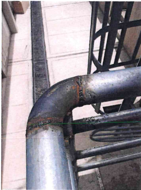
Barandas en rampa 1 con codos de tubo negro
