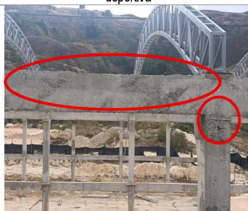
FOTOGRAFÍA N° 12 Cangrejas y fragmentos de ladrillos en viguetas de la losa aligerada inclinada del tercer piso del módulo 13
