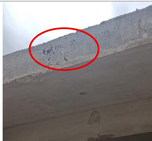
FOTOGRAFÍA N° 10 Viga superior y columna con cangrejas en losa deportiva
