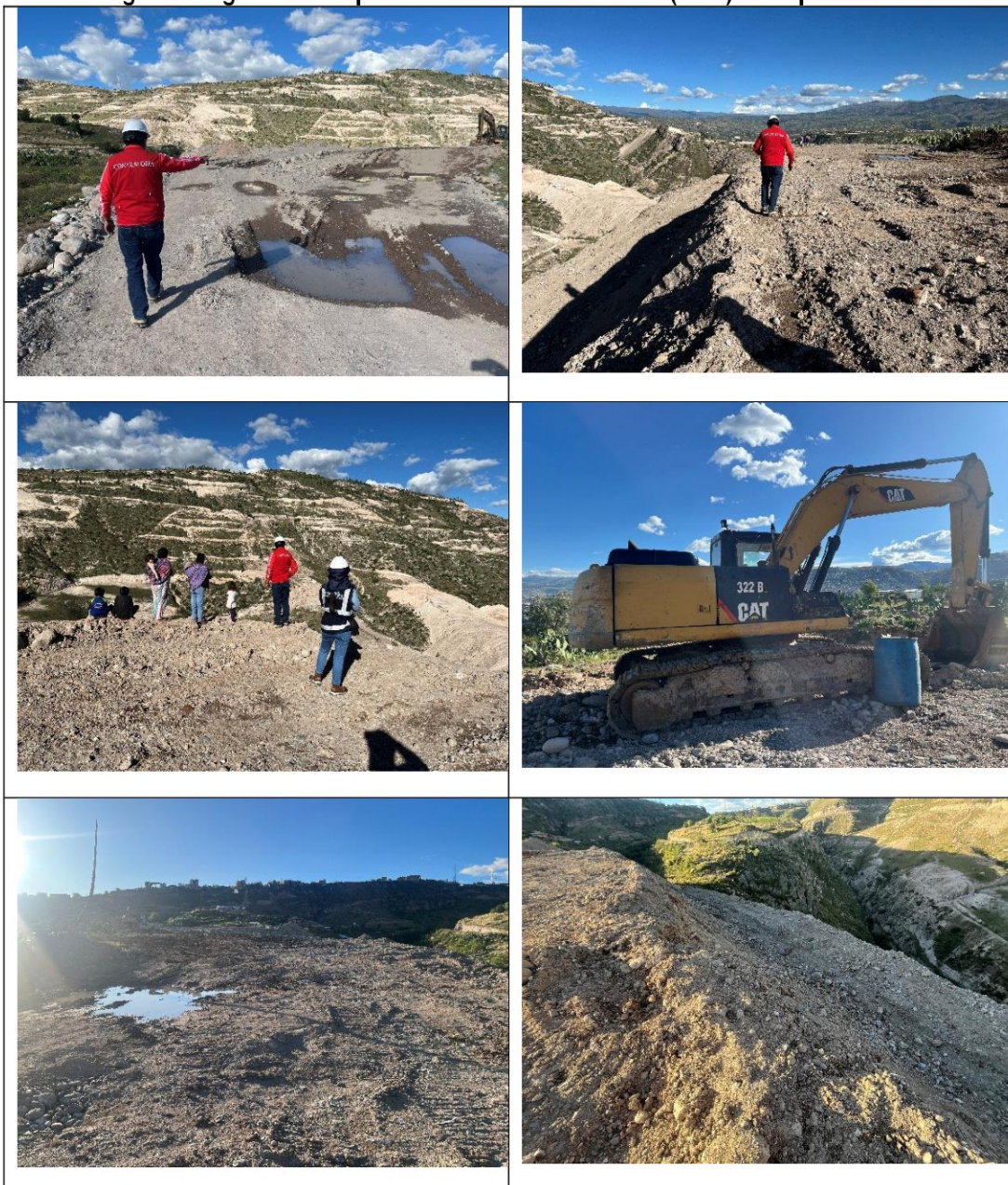
Imágenes n.ºs 12 al 17: Estado situacional del DME Mollepata en el momento de la inspección física realizada el 24 de febrero de 2025.
