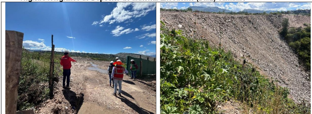
Imagen n.º 22: Se encontró el DME Tambillo cerrado, sin presencia de ninguna actividad de eliminación de materiales.
