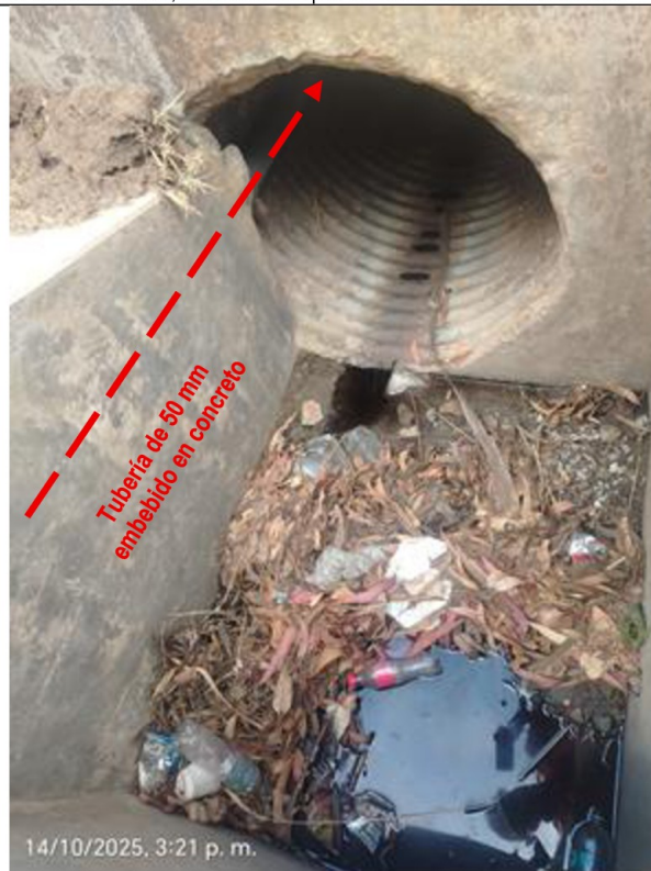
Imagen n.º 11: Vista del ingreso de la descarga alcantarilla TMC donde se instaló la tubería de 50 mm con vaciado de concreto hasta el ingreso, se redujo en 15% la sección de la alcantarilla, además se muestra diversos materiales depositados (plásticos, botellas, arbustos, entre otros) situación que podría afectar el drenaje las aguas superficiales y del agua de lluvia de la carretera (descarga de la cuneta a la alcantarilla).
