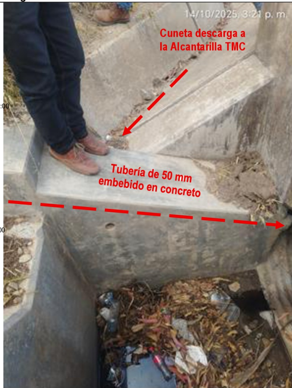
Imagen n.º 11: Vista del ingreso de la descarga alcantarilla TMC donde se instaló la tubería de 50 mm con vaciado de concreto hasta el ingreso, se redujo en 15% la sección de la alcantarilla, además se muestra diversos materiales depositados (plásticos, botellas, arbustos, entre otros) situación que podría afectar el drenaje las aguas superficiales y del agua de lluvia de la carretera (descarga de la cuneta a la alcantarilla).
