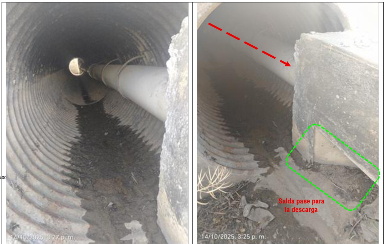
Imágenes n.ºs 08 y 09: Vista al interior de la alcantarilla TMC donde se instaló la tubería de 200 mm anclado con aros de fierro corrugado soldado a la alcantarilla metálica.
