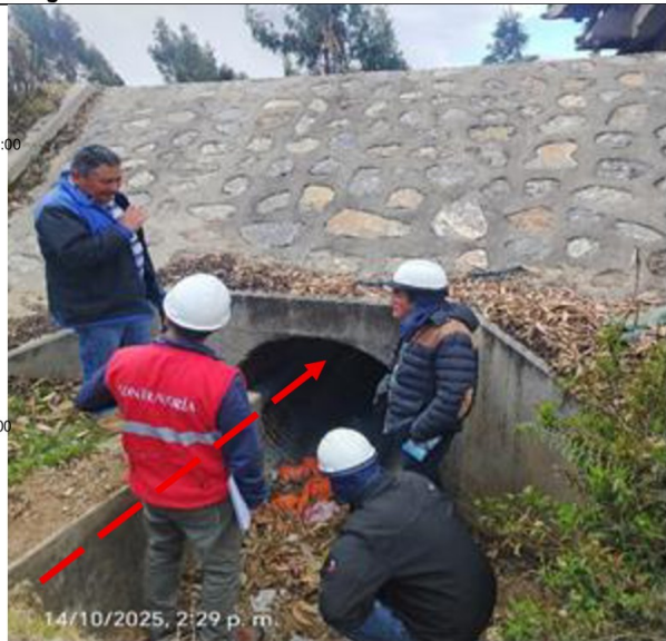
Imágenes n.ºs 17 y 18: Vista del ingreso de la descarga alcantarilla TMC donde se instaló la tubería de 160mm con vaciado de concreto hasta el ingreso, se redujo en 30% la sección de la alcantarilla, además se muestra diversos materiales depositados, situación que podría afectar el drenaje las aguas superficiales y del agua de lluvia de la carretera.
