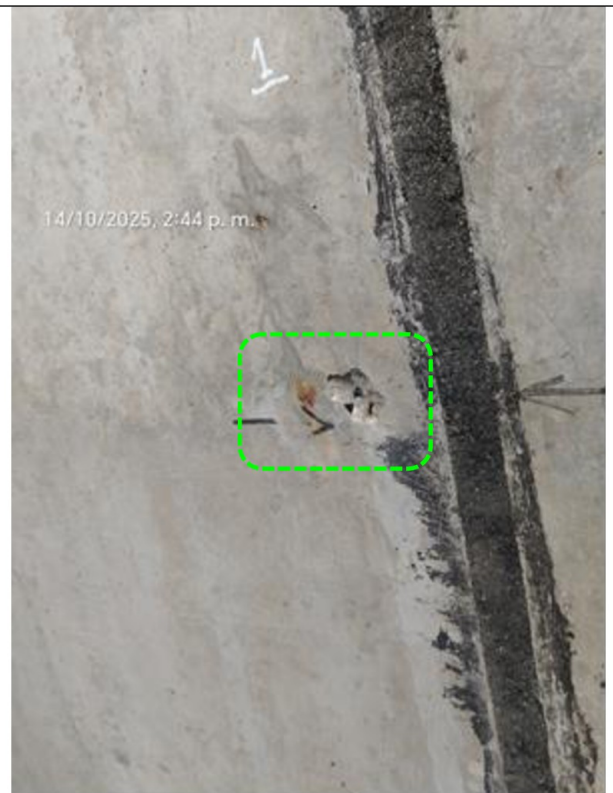
Imagen n.º 59: Vista de cangrejera y presencia de oxido en alambre n.º 8, utilizado para el encofrado embebido en la estructura del reservorio.
