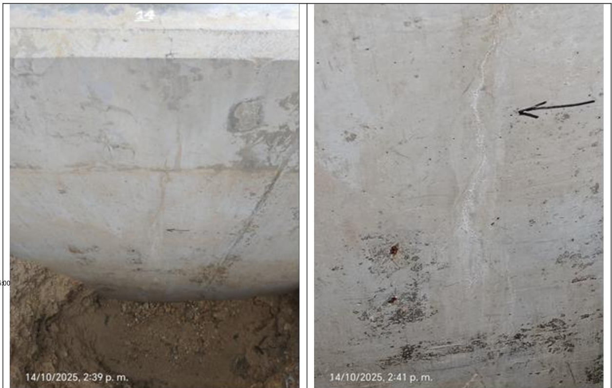
Imágenes n.ºs 46 y 47: Vista del punto 14, fisuras verticales con presencia de salitre (color blanco) como depósitos cristalinos y polvorientos en las paredes del muro, debido a la presencia de humedad.
