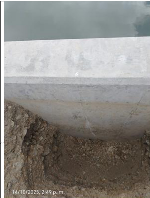
Imágenes n.ºs 42 y 43: Vista del punto 6, fisuras verticales con presencia de salitre (color blanco) como depósitos cristalinos y polvorientos en las paredes del muro, debido a la presencia de humedad.
