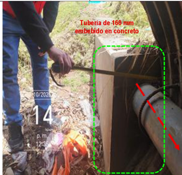
Imágenes n.ºs 17 y 18: Vista del ingreso de la descarga alcantarilla TMC donde se instaló la tubería de 160mm con vaciado de concreto hasta el ingreso, se redujo en 30% la sección de la alcantarilla, además se muestra diversos materiales depositados, situación que podría afectar el drenaje las aguas superficiales y del agua de lluvia de la carretera.
