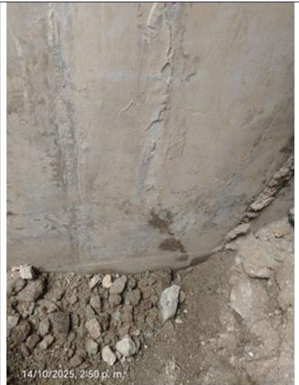
Imágenes n.ºs 44 y 45: Vista del punto 7, fisuras verticales en las paredes del muro y presencia de humedad en la parte baja.
