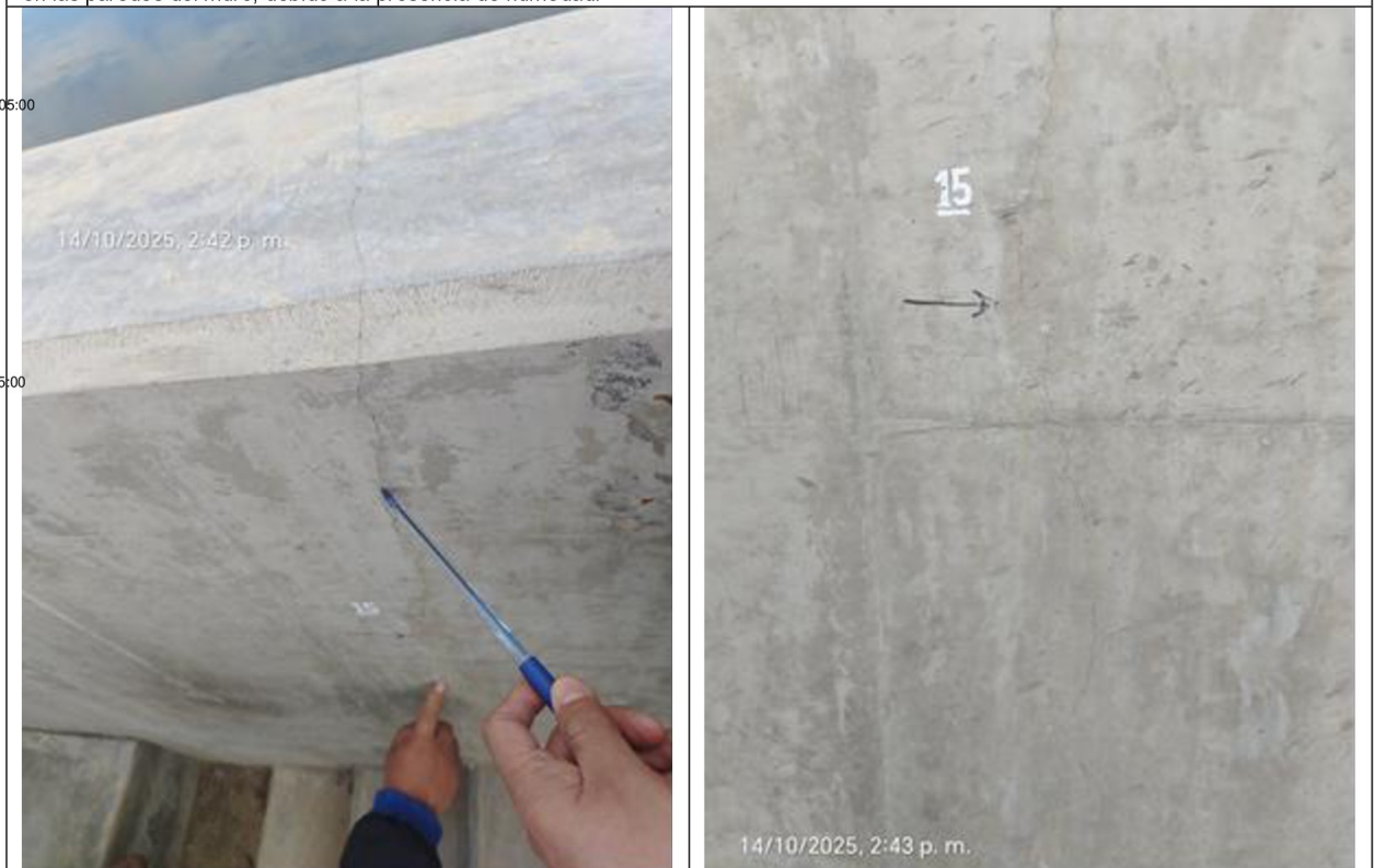
Imágenes n.ºs 48 y 49: Vista del punto 15, con presencia de fisuras verticales
