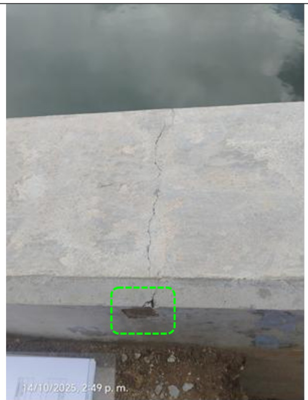
Imágenes n.ºs 56 y 57: Vista de la presencia de escantillón de madera embebido en la estructura de la corona que se visualiza en la cara exterior del muro.
