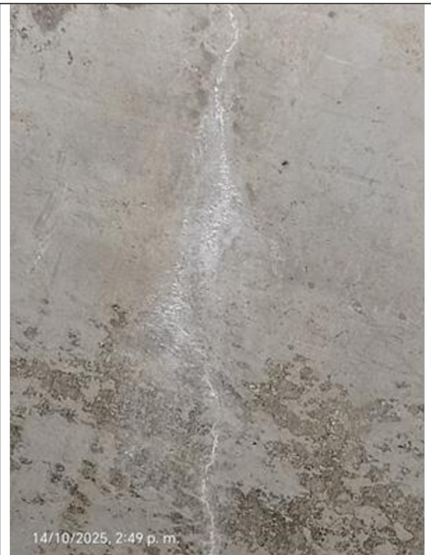
Imágenes n.ºs 42 y 43: Vista del punto 6, fisuras verticales con presencia de salitre (color blanco) como depósitos cristalinos y polvorientos en las paredes del muro, debido a la presencia de humedad.
