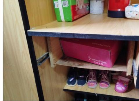
**Imagen n.º 32:** cajones en mal estado, sin tapas y con clavos expuestos (Hogar n.º 9, Hogar n.º 6,
