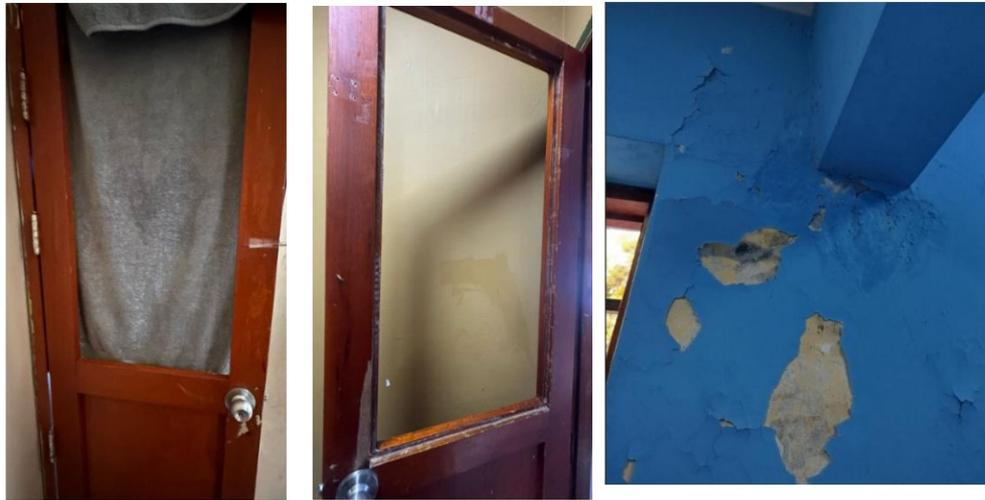
**Imagen n.º 29:** uso de toalla de manera provisional, puerta de baño sin cristal (Hogar n.º 4) y paredes del baño con presencia de humedad (Hogar 7)
