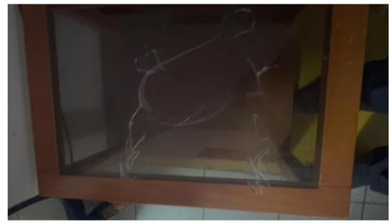
**Imagen n.º 35:** ropero con presencia de moho en interiores y esquinas (Hogar n.º 8)
