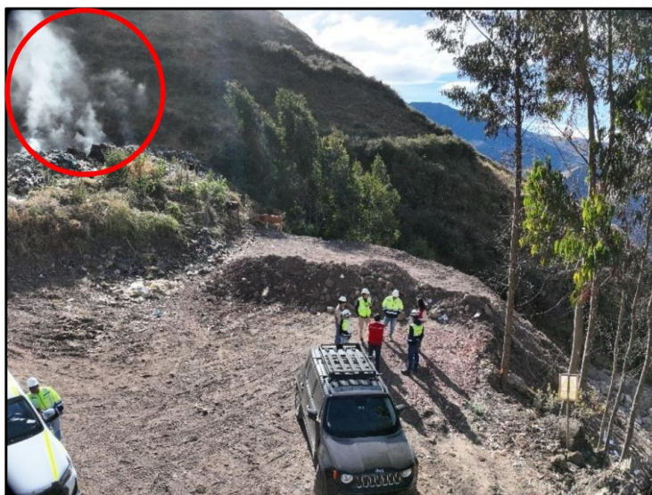
Fuente: Inspección física a la obra de 1 y 2 de julio de 2025.
