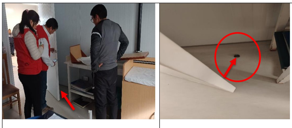
FOTOGRAFÍAS N°s 3 Y 4 DETALLE DEL COLOCADO DE LAS PUERTAS IMANTADAS
