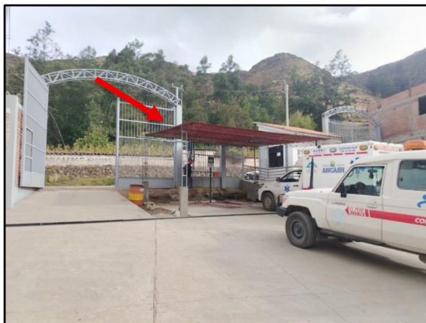
Fuente: Inspección física a la obra de 1 y 2 de julio de 2025. Elaborado por: Comisión de control.
