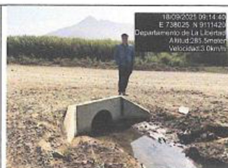
Fotografía n.º 2: Alcantarilla TMC ubicado en el km 0+140.
