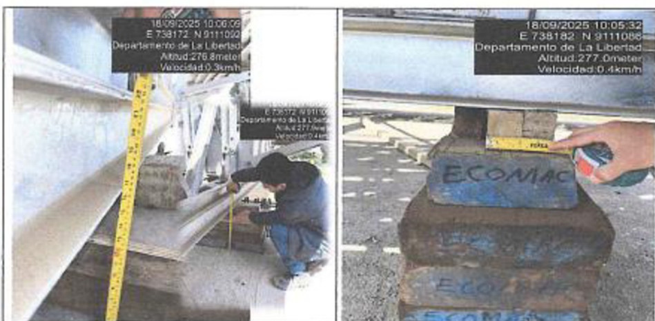
Fotografías n.º 13 y 14: Maderas de estiba que sirven como apoyos temporales, vienen soportando el peso de la estructura desde el mes de mayo de 2025 debido a que no se culminó con el lanzamiento del puente modular por la resolución del contrato de ejecución; y en algunos casos tiene un ancho mínimo de 5 cm, además, se advierte el deterioro del referido material. (Estrido izquierdo)
