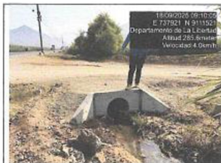
Fotografía n.º 1: Alcantarilla TMC ubicado en el km 0+000.
