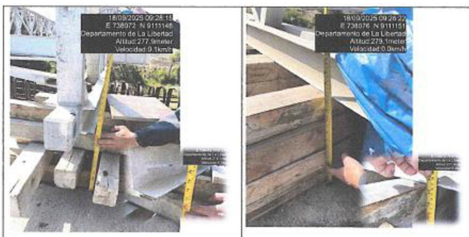
Fotografías n.º 11 y 12: Maderas de estiba que sirven como apoyos temporales, vienen soportando el peso de la estructura desde el mes de mayo de 2025 debido a que no se culminó con el lanzamiento del puente modular por la resolución del contrato de ejecución; y en algunos casos tiene un ancho mínimo de 5 cm, además, se advierte el deterioro del referido material. (Estrido derecho)
