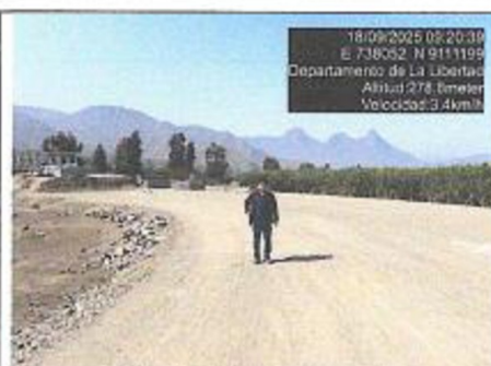
Fotografías n.º 3 y 4: Segregación de material fino en el acceso derecho al puente Menocucho, entre el km 0+000 al km 0+460.
