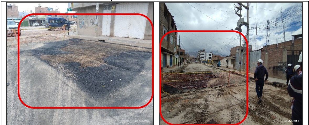
Imagen n.º 20: Carpeta asfáltica de 2" pendiente de ejecución en la Jirón Martí cuadra 7.
