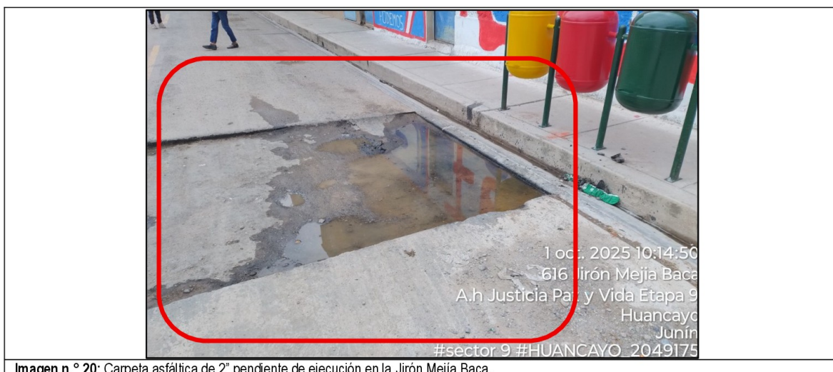
Imagen n.º 20: Carpeta asfáltica de 2" pendiente de ejecución en la Jirón Mejía Baca.
