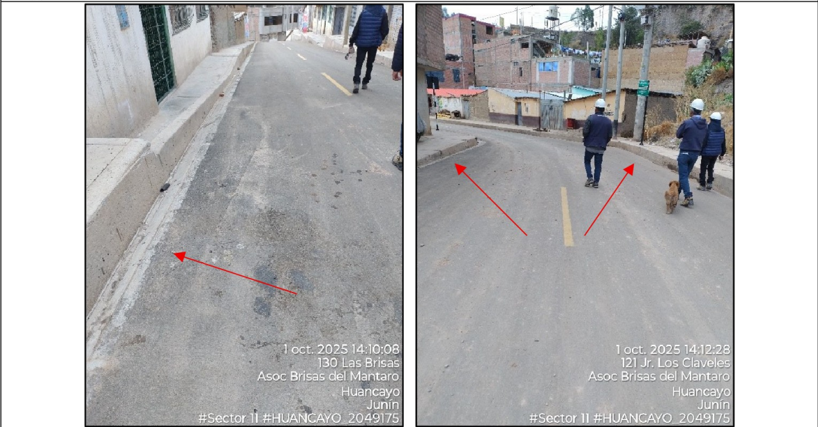
Imagen n.º 20: 02.06.002 Líneas continuas laterales en el pavimento sin ejecución, en la calle los insurgentes y Bruno Terreros (sector n.º 13).
