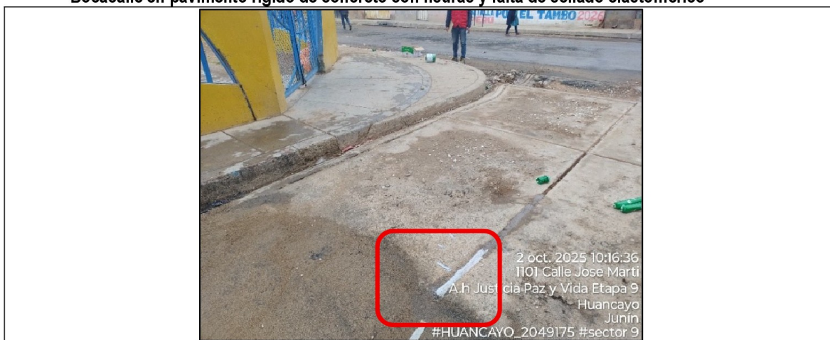
Imagen n.º 20: Colocación de sello elastomérico en un ambiente de poca limpieza, ubicado en la bocacalle de Calle José Martí (sector n.º 9).
