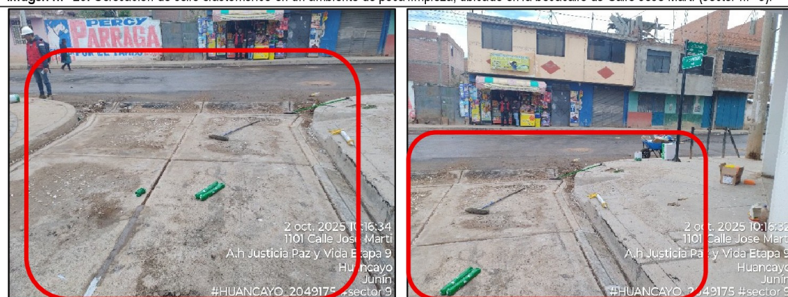
Imagen n.º 21: Colocación de sello elastomérico en un ambiente de poca limpieza, ubicado en la bocacalle de Calle Jose Martí (sector n.º 9).
