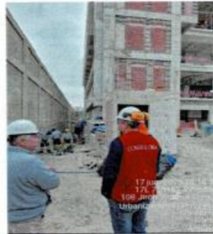
Actividades de Bandejas eléctricas, tuberías para gases medicinales, aire comprimido y vacío.
