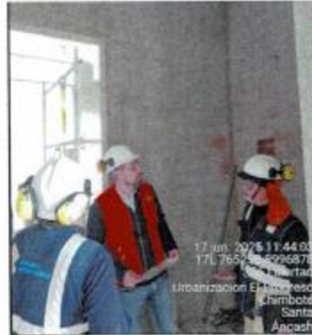
Actividades de Tarrajeo Primario
