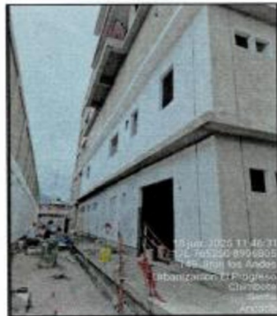
Aplicación Base para Pintura – Exteriores – Block A y cerco perimétrico.
