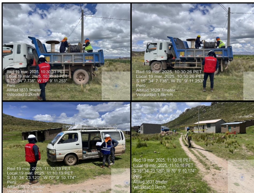
Fotografías n.ºs 27, 28, 29 y 30 Trabajadores en ejecución de obra el 19 de marzo de 2025.
