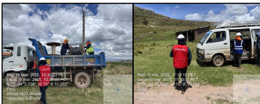
Fotografías n.ºs 21, 22, 23 y 24 Comisión de Control presente en la Obra
